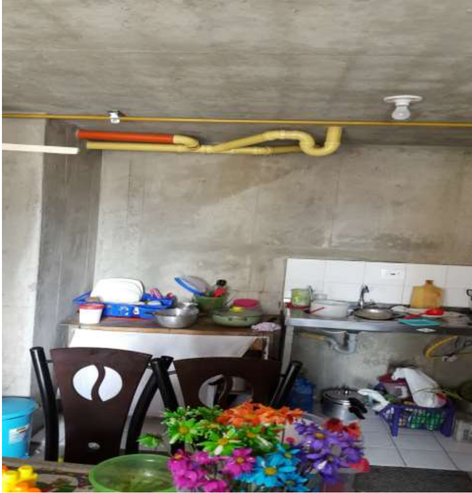
Foto del Interior de una vivienda en obra gris, proyecto plaza de la Hoja, tomada por Juan Ernesto Páez Mejía.
