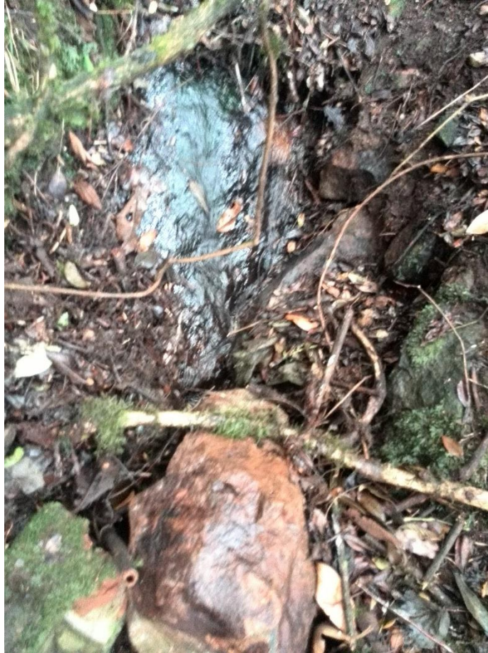
Ilustración 13 Fotografía - No existe un buen sistema de aducción
