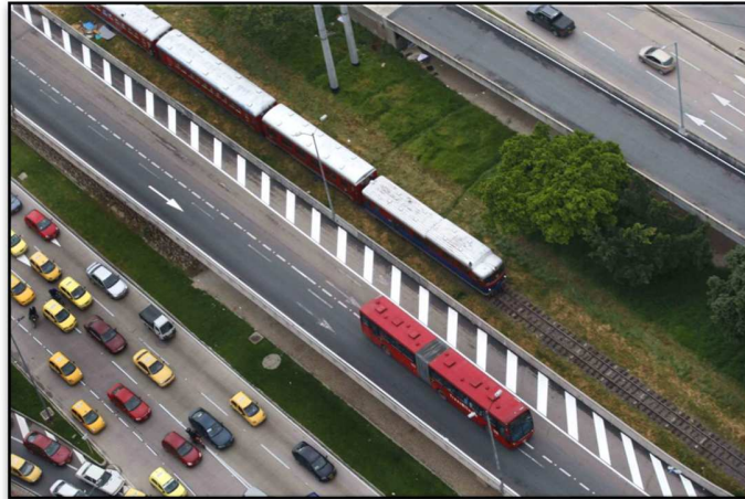
Figura 8. Vías para servicios Troncales Fuente: www.transmilenio.gov.co
