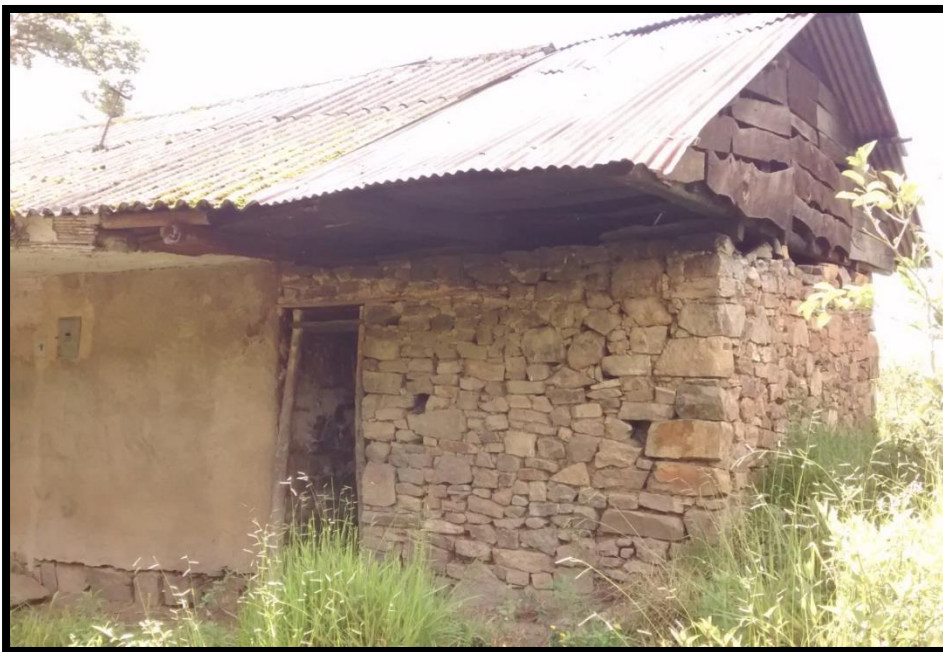
FIGURA17. Construcción de viviendas en piedra. Fuente: Propia
