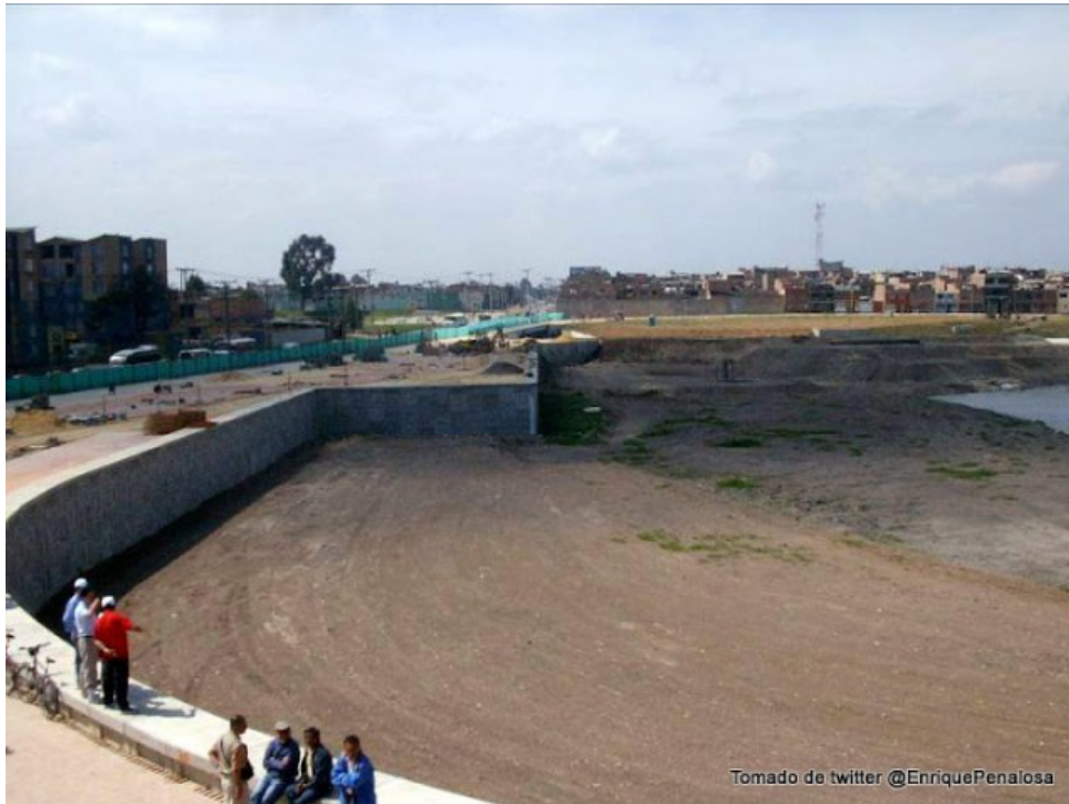
Fotografía 2 Obras civiles Juan Amarillo 2003
