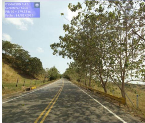
Figura 10. Defensa Metálica en el PR 90+180
