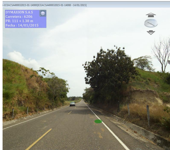
Figura 7. Ejemplo Talud a media ladera en la vía
