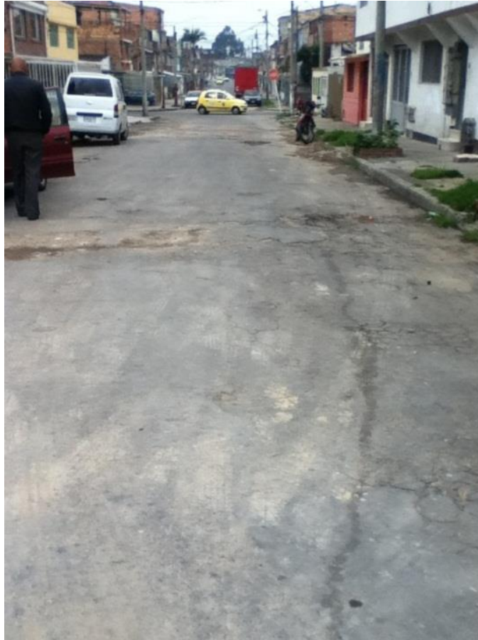
Ilustración 4: fotografía vía a intervenir
