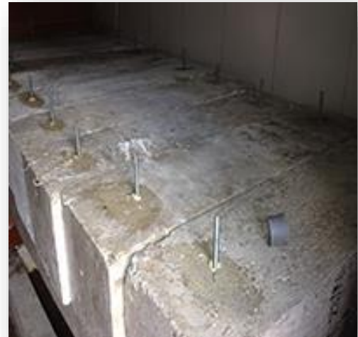
Figura 15. Viga para ser ensayada
