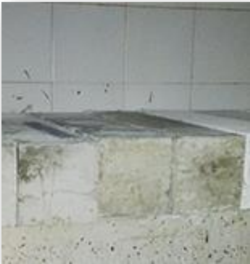
Figura 8. Curado de Vigas
