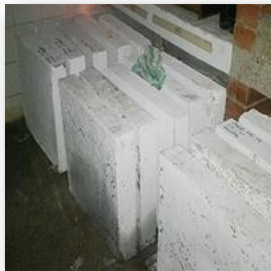
Figura 9. Curado de Losas
