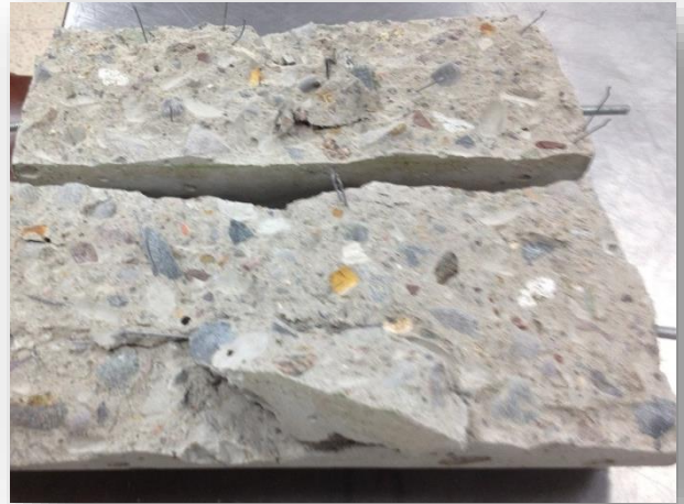
Figura 24. T.I, Cilindro Fallado
