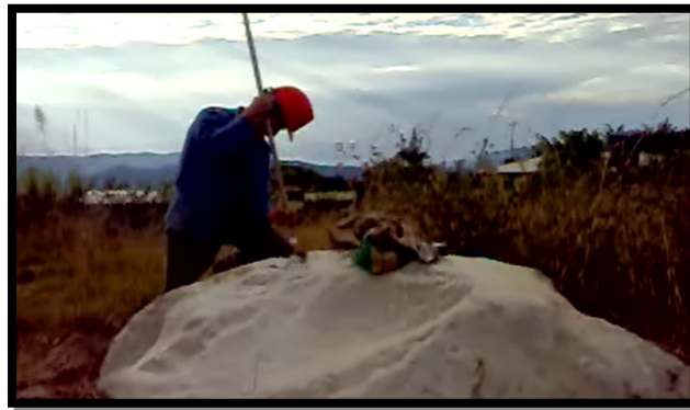
Ilustración 26 Cargue del barreno artesanal fuente propia
