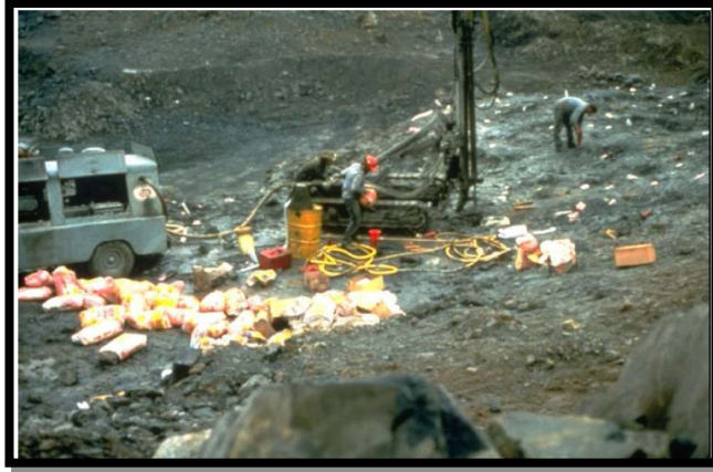
Ilustración 30. Desorden con el uso de explosivos. Fuente Propia
