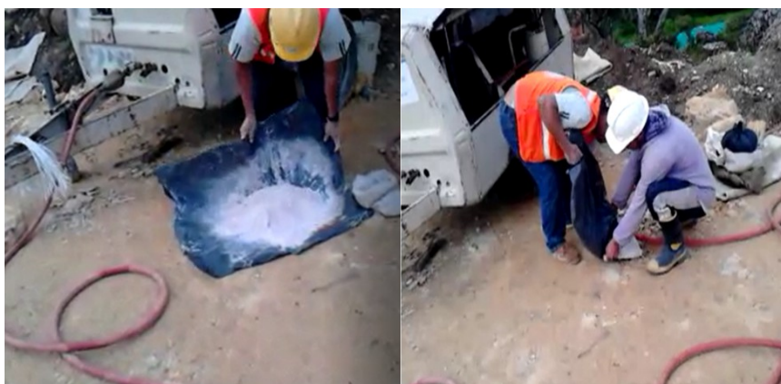
Ilustración 23 Manipulación inadecuada de explosivos artesanales fuente propia
