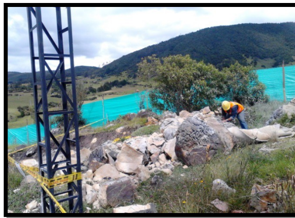
Ilustración 16 Presencia de material rocoso en proceso de cimentación. Fuente propia
