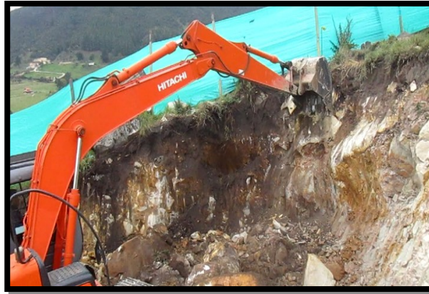
Ilustración 15 Presencia de materia l rocoso en proceso de cimentación. Fuente propia
