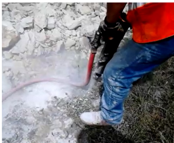
Ilustración 19 Perforación por Rotopercusión Fuente Propia
