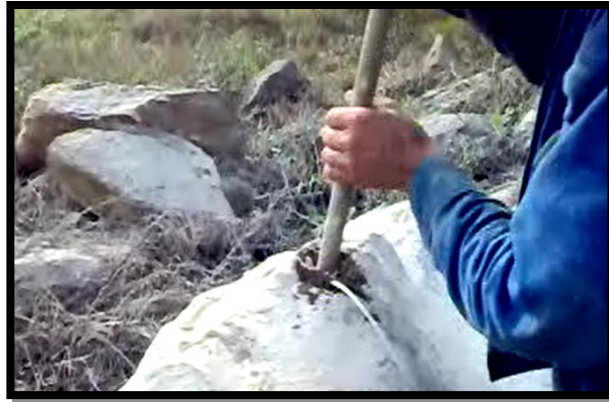
Ilustración 25 Cargue del barreno artesanal fuente propia
