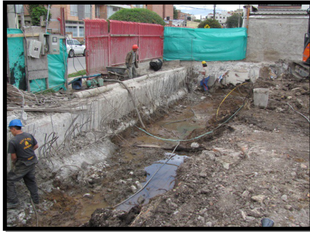
Ilustración 14 Viga guía en obra Fuente constructorasanfrancisco.co
