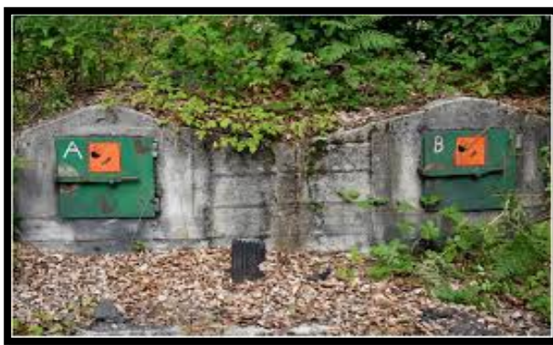
Ilustración 37. Correcto almacenamiento y descarga de estática fuente
