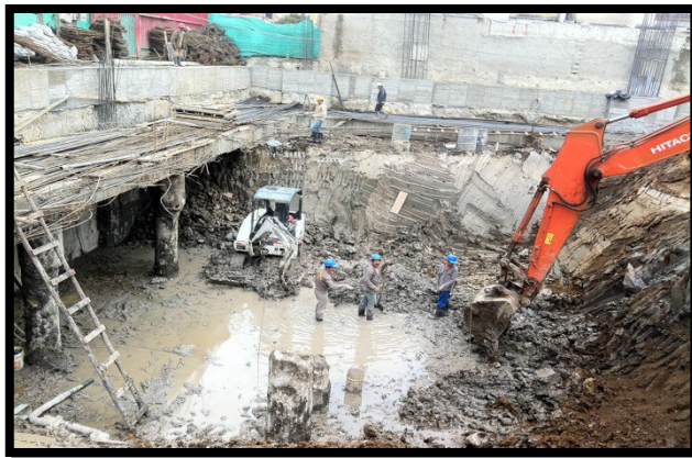
Ilustración 11 Pilotes que necesitan ser descabezados en obra. Fuente
