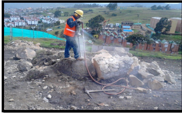
Ilustración 4 Perforación a un elemento –Barreno. Fuente propia
