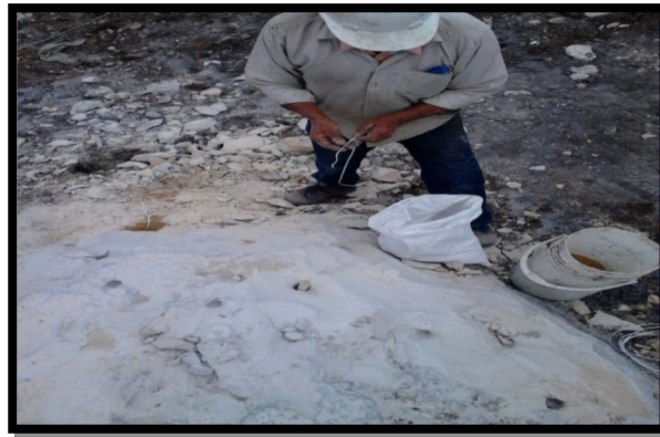
Ilustración 5 Perforación a un elemento –Barreno. Fuente propia
