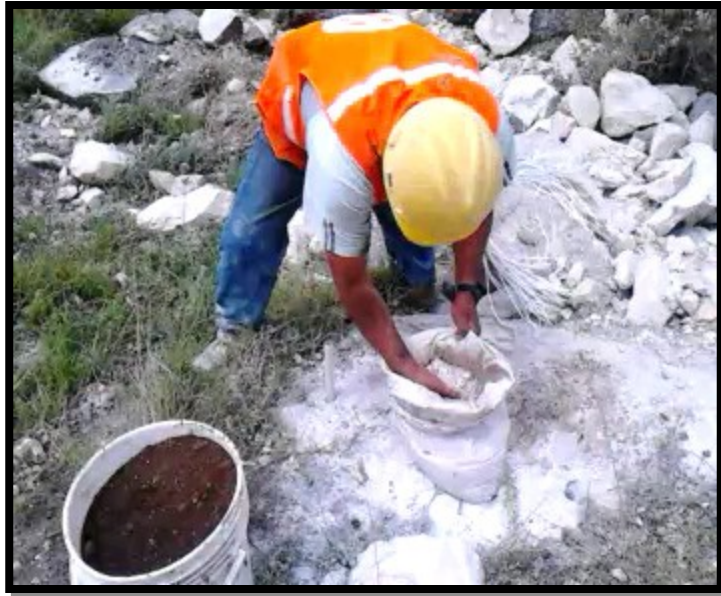
Ilustración 40 forma incorrecta de llevar explosivos y accesorios de voladura, fuente propia
