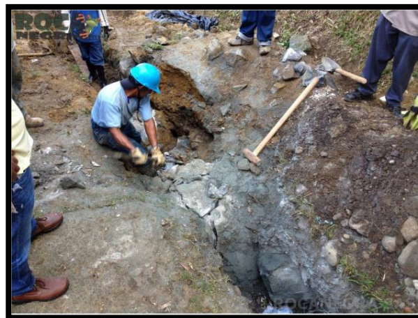
Ilustración 17 Fracturación de roca dentro de la ejecución de una cimentación
