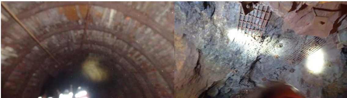
Figura 20 Enmallado sintético de alta resistencia de techos
