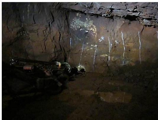
Figura 55 Perforación con jumbo.
