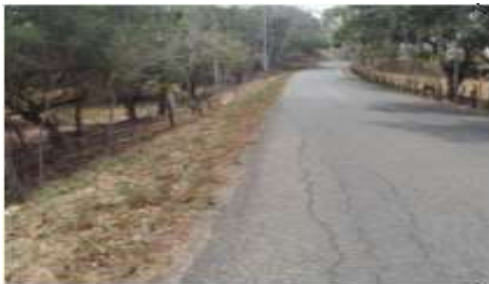
Figura n° 3. Estado de la vía antes y después de la intervención k28+150 - k28+450 fisuras longitudinales de borde por falla del hombro del terraplén.
