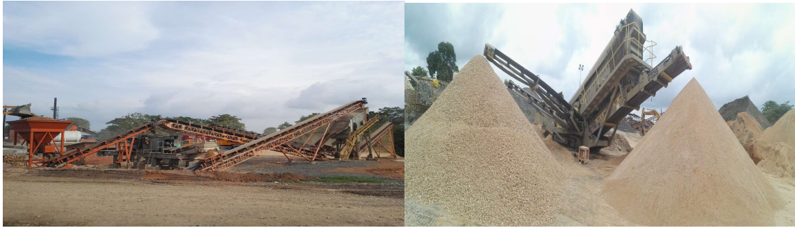
Figura N° 13. Acopio material mezcla.
