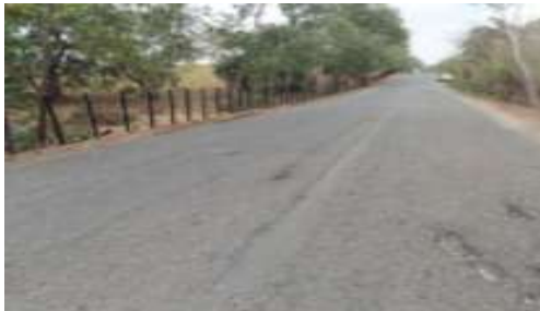
Figura n° 2. Estado de la vía antes y después de la intervención k26+450 - k27+350 fisuras longitudinales de borde por falla del hombro del terraplén.
