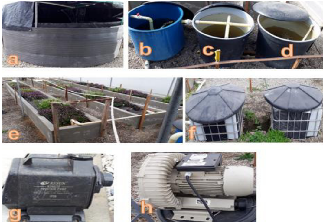
Figura 8. Componentes del sistema acuapónico. a: Tanque de peces, b: Hidrociclón, c: Clarificador, d: Biofiltro, e: Camas de producción, f: Sumideros, g: Bomba eléctrica, h: Turbina de aireación (Santos y Pandales, 2016).
