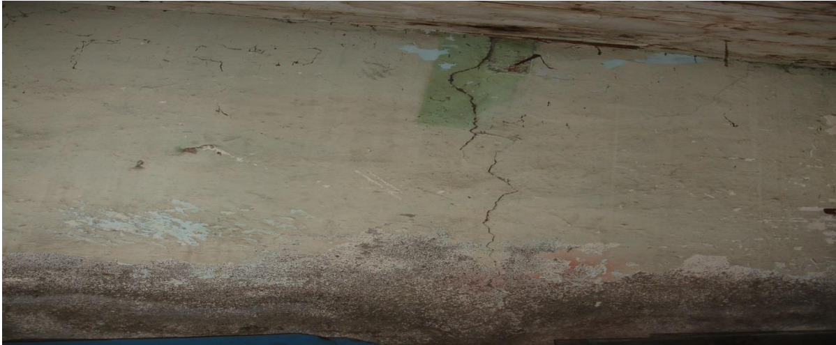
Figura 25 Repellos existentes vivienda de un piso
