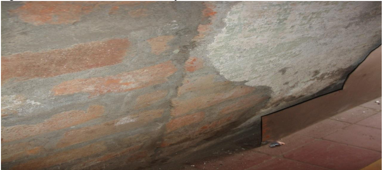
Figura 24 Muros existentes vivienda de un piso
