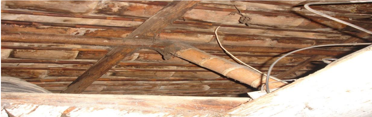
Figura 21 Cubierta y cielo falso existente vivienda de un piso
