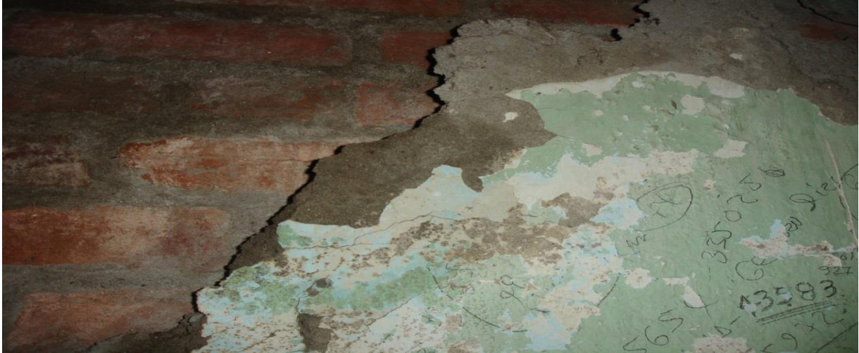
Figura 23 Muros y repellos existentes vivienda de un piso
