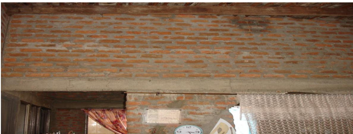
Figura 33 Muros interiores vivienda de dos pisos
