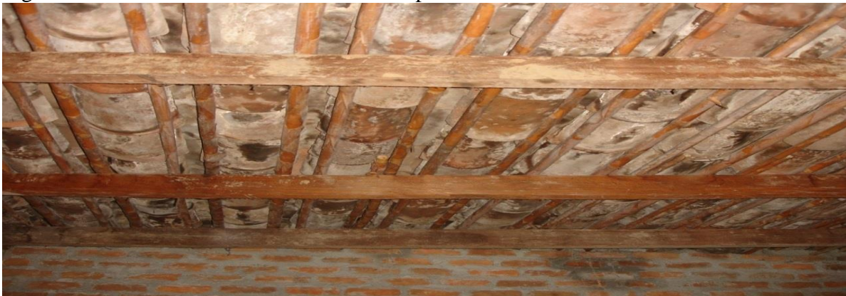
Figura 32 Cubierta existente vivienda de dos pisos
