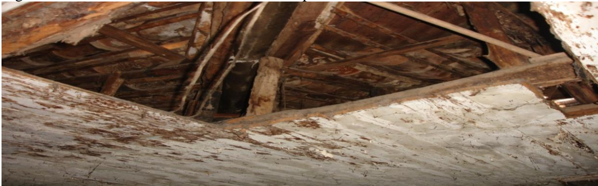
Figura 22 Cielo falso existente vivienda de un piso
