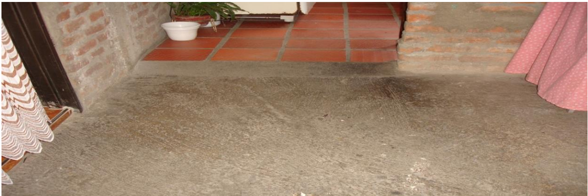
Figura 35 Pisos interiores existentes vivienda de dos pisos
