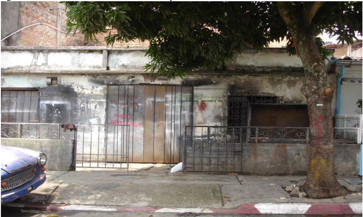
Figura 20 Fachada existente vivienda de un piso
