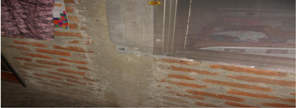
Figura 34 Mampostería ladrillo común vivienda de dos pisos
