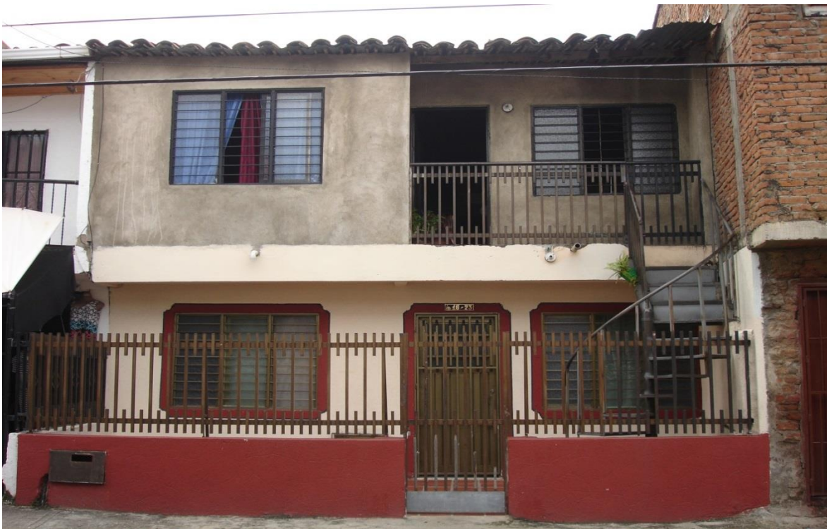
Figura 31 Fachada existente vivienda de dos pisos
