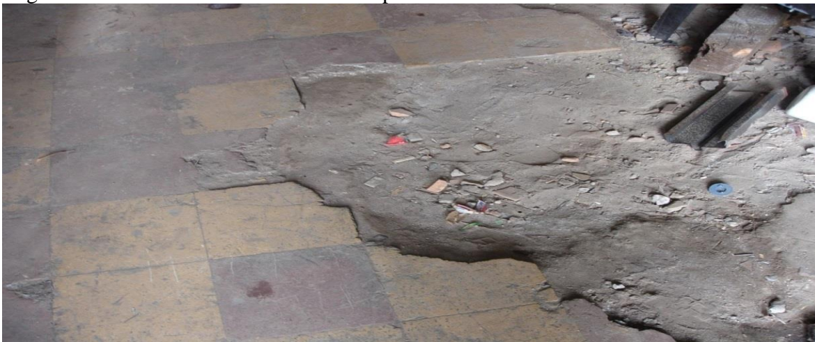
Figura 26 Pisos existentes vivienda de un piso
