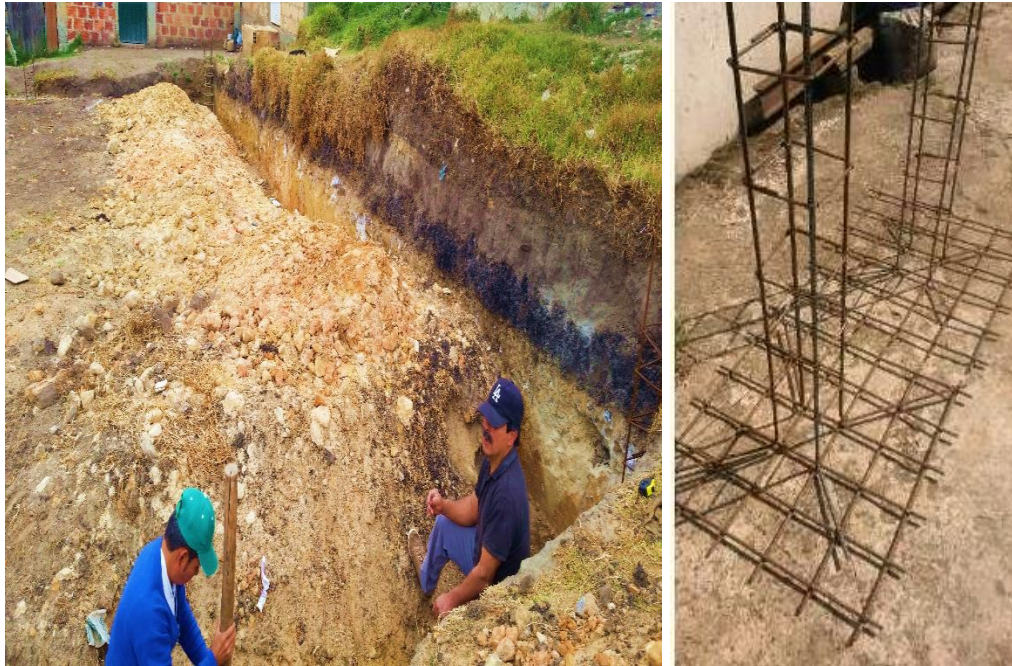
Figura 19. Excavación para zapatas y nivelación
