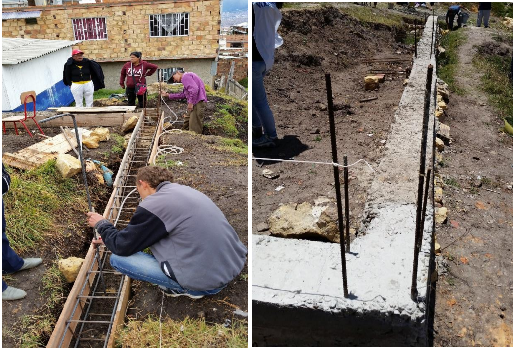
Figura 22. Colocación de canastas y encofrado para vigas de cimentación
