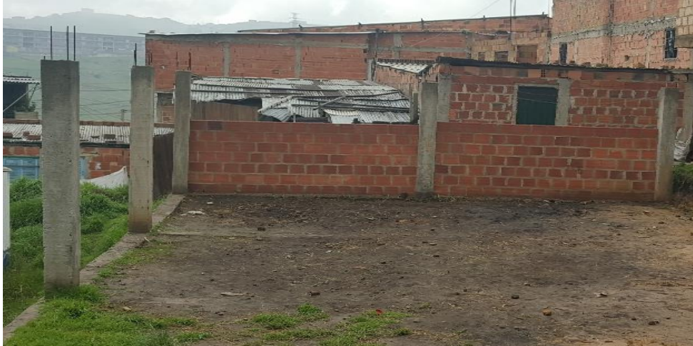
Figura 31. Muro en mampostería convencional
