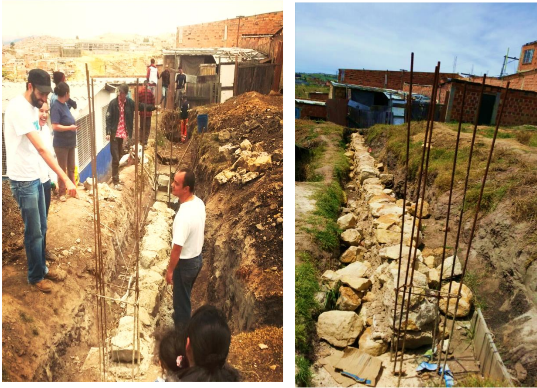
Figura 20. Alzado de cimiento ciclópeo
