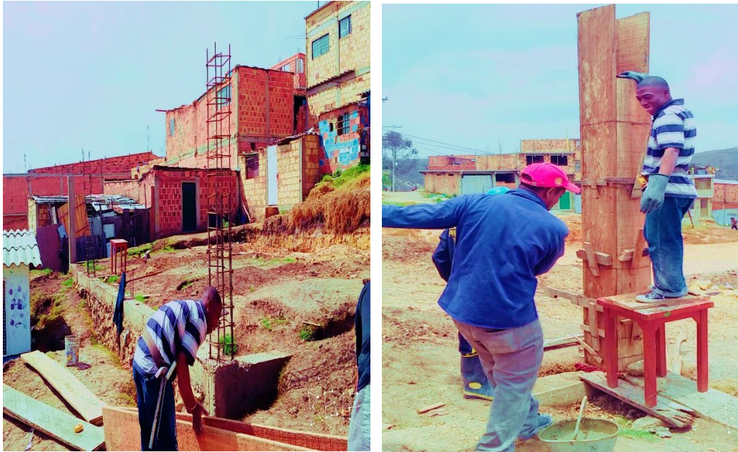
Figura 24. Armado de canasta y encofrado de columna
