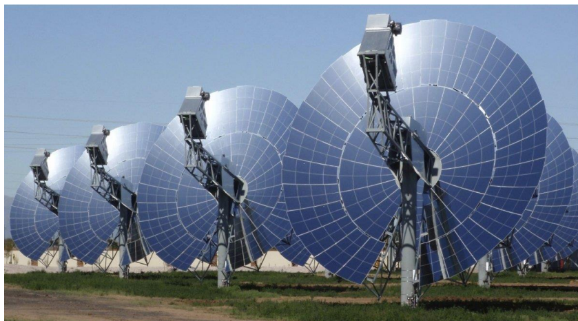
Figura 2.7 Central Termo-Solar de Discos Parabólicos con motor Stirling [29].
