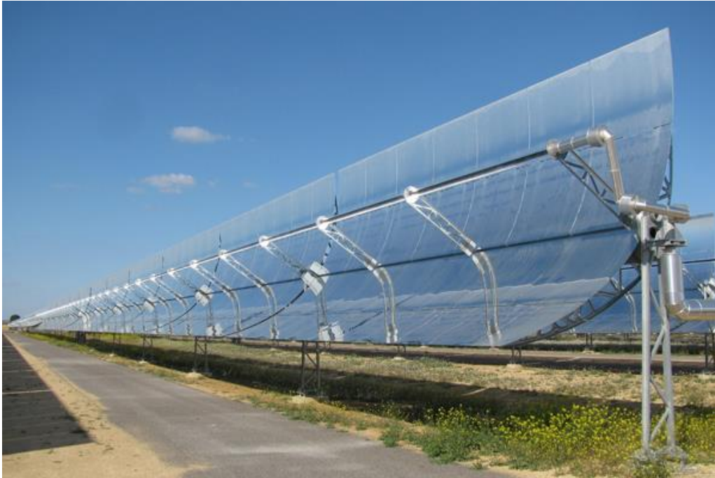
Figura 2.6 Planta solar Valle 1 ubicada en Cádiz, España. [28]
