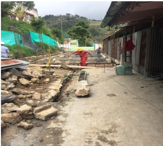
Figura 28. Amarre flejes columnas cocinas.
