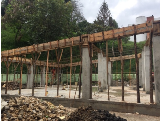
Figura 26. Formaleta lista vigas aéreas baños.
