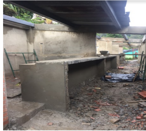
Figura 45. Terminación muros cocinas.
