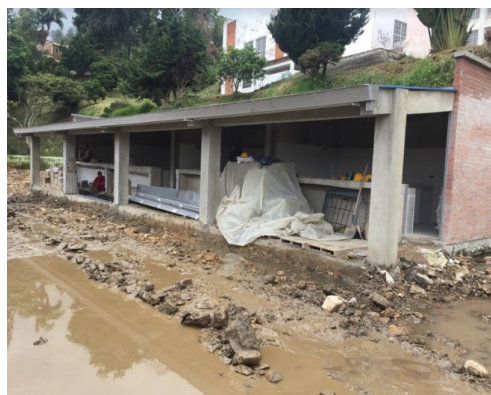
Figura 50. Colocación estructura metálica.
