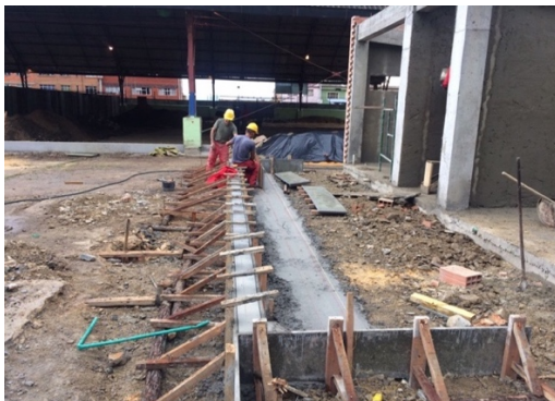
Figura 35. Actividades finales mampostería baños.
