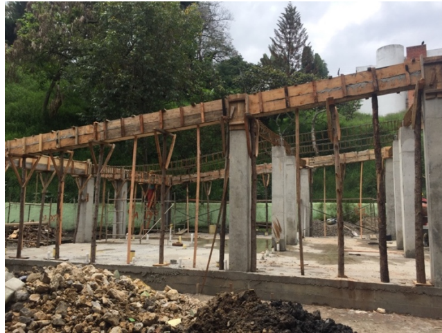
Figura 8. Ejemplo columna aérea.
