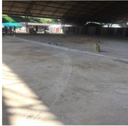
Figura 41. Bordillo placa zona comercial.
