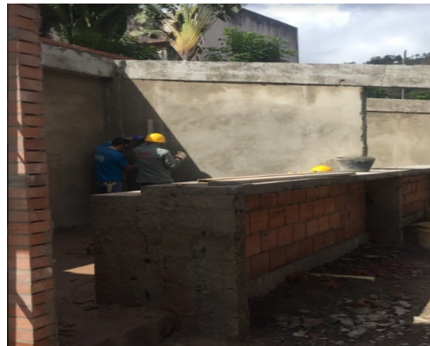
Figura 40. Actividades finales mampostería cocinas.
