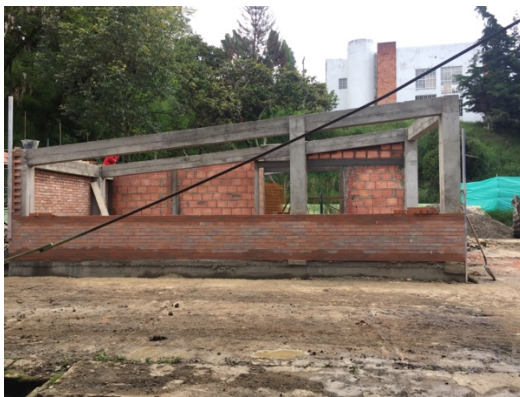
Figura 30. Avance mampostería baños.
