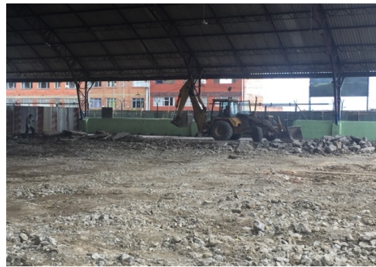
Figura 16. Demolición placa contrapiso antigua.
