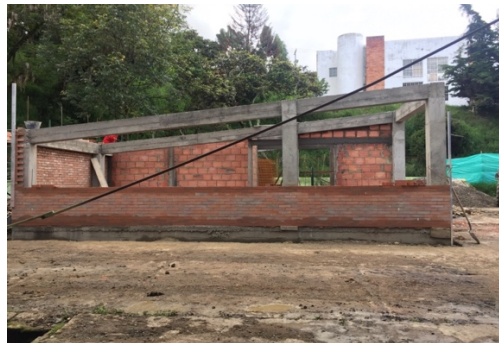
Figura 9. Ejemplo muros en mampostería.
