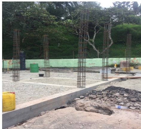
Figura 19. Zapatas y vigas de amarre terminadas.
