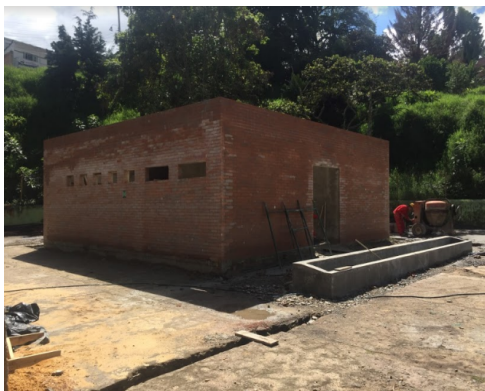
Figura 39. Mampostería baños terminada.
