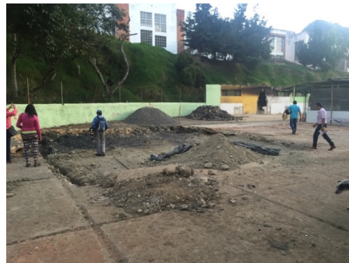
Figura 12. Avances en demolición.
