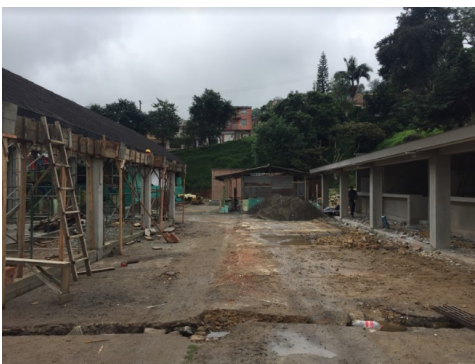
Figura 48. Construcción cocinas faltantes.
