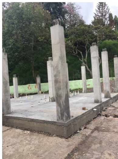
Figura 7. Ejemplo viga de amarre.
