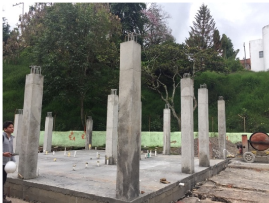
Figura 21. Columnas baños terminadas.
