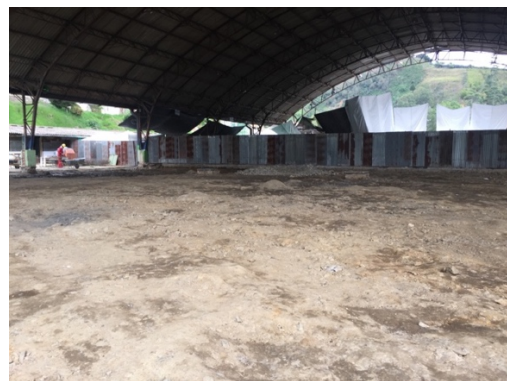
Figura 22. Placa contrapiso sin avance.
