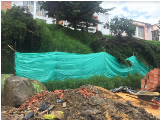
Figura 42. Caída arboles talud aledaño a la plaza.
