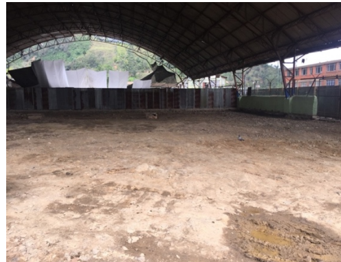
Figura 27. Placa de contrapiso sin avance.
