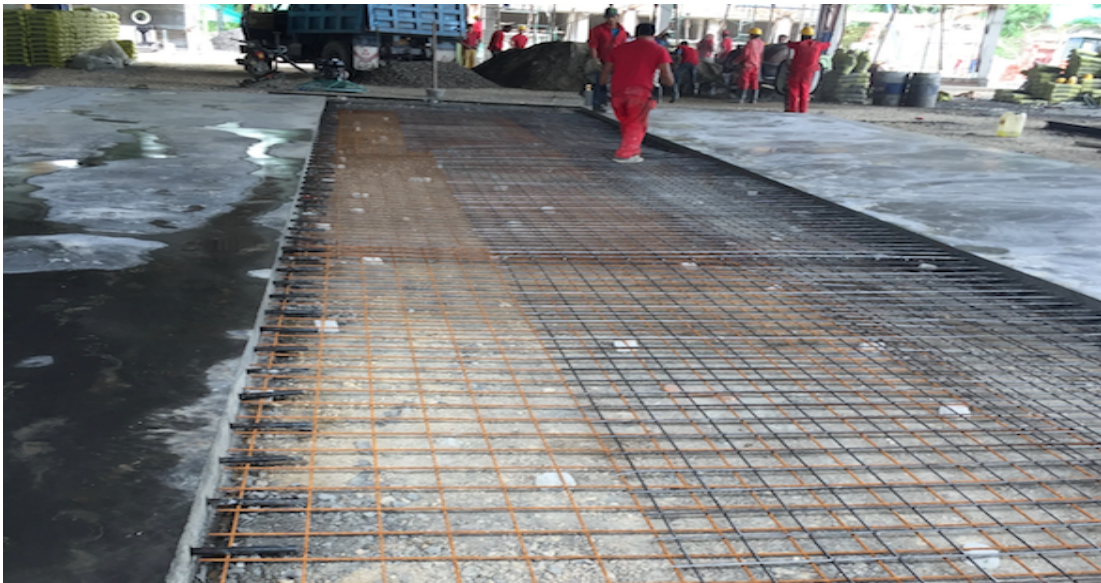
Figura 4. Ejemplo losa de contrapiso.
