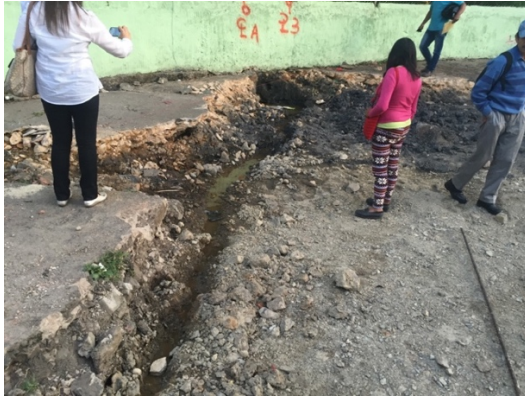
Figura 13. Avances en demolición.
