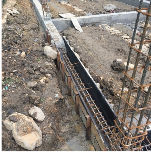
Figura 6. Ejemplo viga de amarre.
