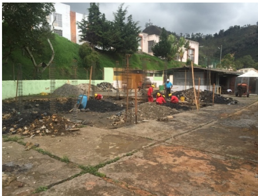
Figura 15. Inicio refuerzo columnas baños.
