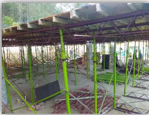
Armado de formaleta
