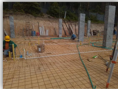
Red hidráulica y eléctrica
