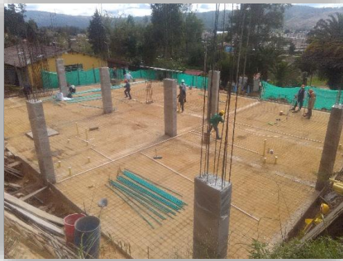
Recebo compactado e instalación de malla electrosoldada
