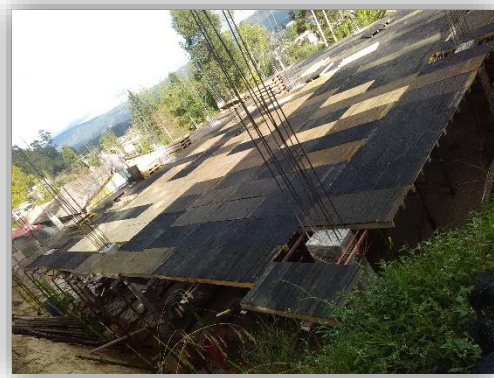
Instalación de camillas
