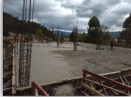
Placa de entrepiso en concreto de 3000 psi
