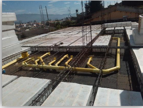
Armado de hierro, instalación red Sanitaria, instalación de casetón
