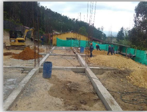
Viga de cimentación
