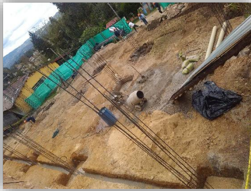
Zapatas en concreto
