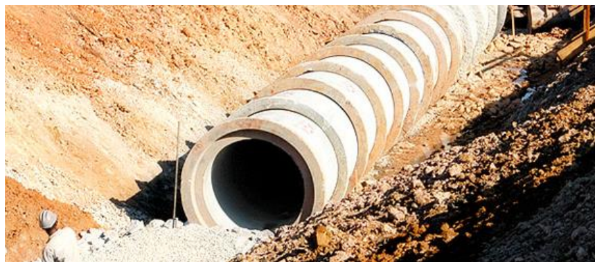
Ilustración 10 Tubería en concreto reforzado colocada. http://www.abtc.com.br
