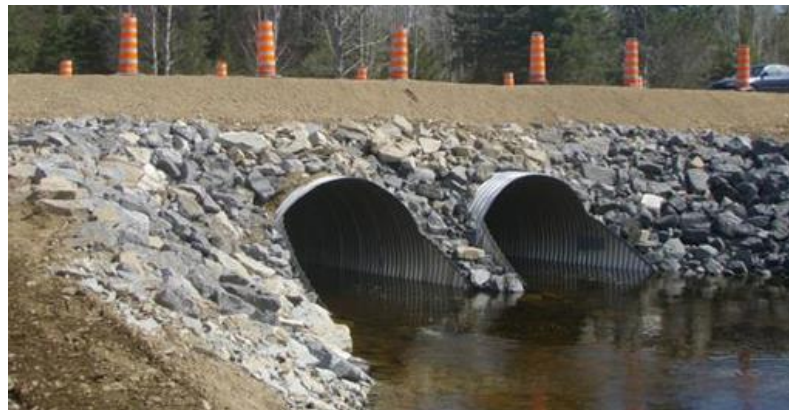
Ilustración 8 Tubería metálica corrugada colocada. www.aill.ca
