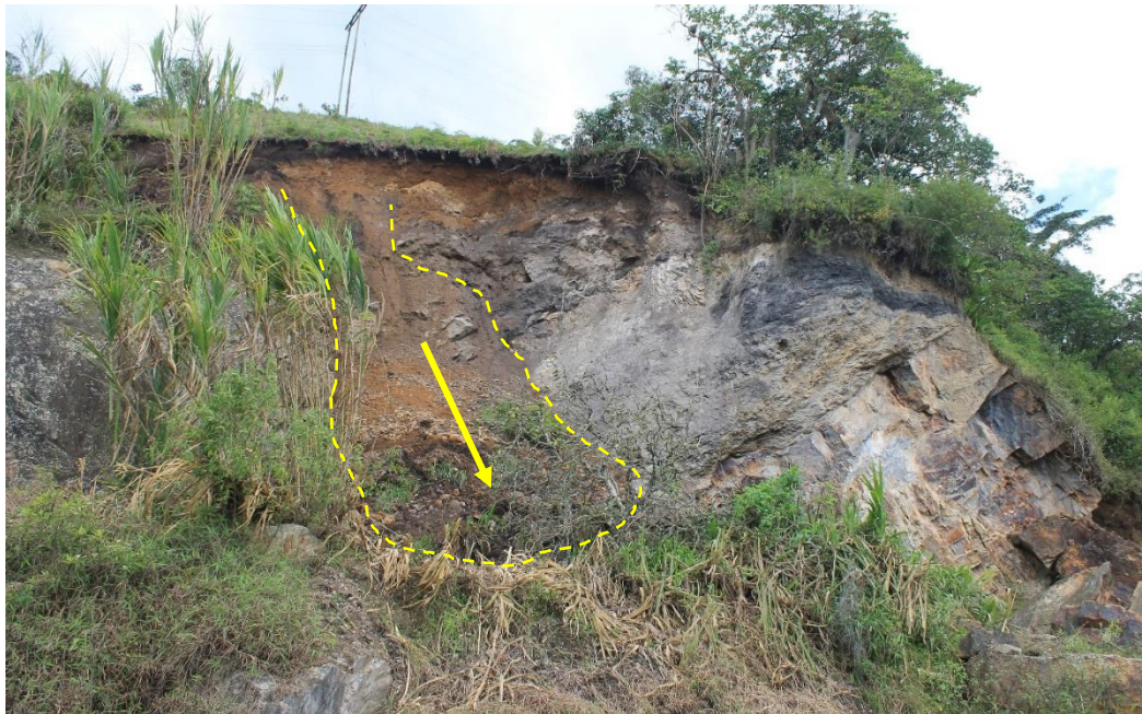
Figura 22: Afloramiento ubicado sobre la margen derecha del carreteable Choachí-La Calera (Kilómetro 12). Las líneas punteadas delimitan el movimiento y la flecha indica su dirección.
