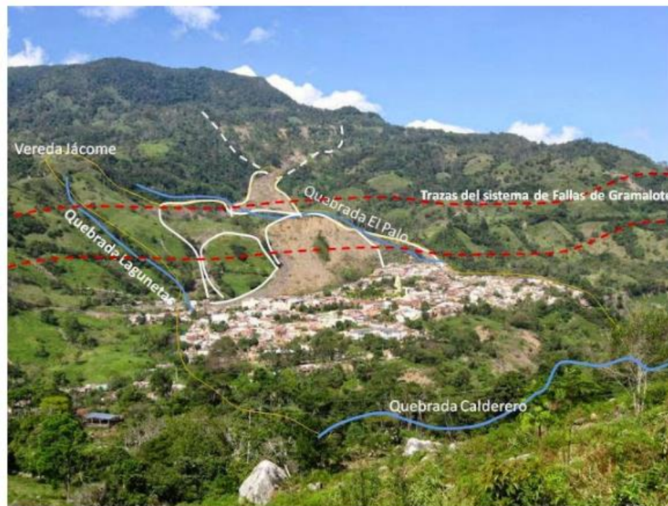
Figura 16: a) La imagen satelital muestra las unidades cretácicas en el área del movimiento y los trazos del Sistema de Fallas de Gramalote. b) La fotografía detalla el área de influencia del coluvión, el cual se encuentra limitado por las dos quebradas que fluyen en sentido oeste-este. También se observan evidencias de los primeros movimientos en la parte alta de la ladera, los flujos y el posterior deslizamiento. Imágenes tomadas de (Pedroza, 2012)
