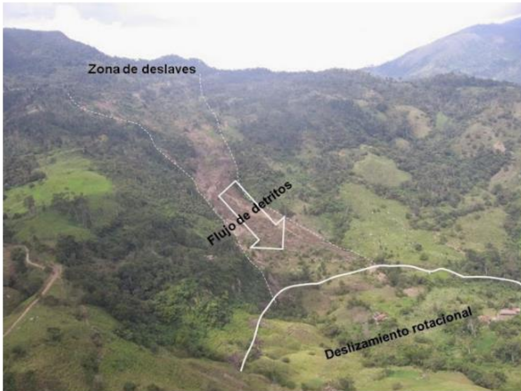
Figura 15: Movimiento de masa tipo compuesto que involucró un flujo previo a un deslizamiento de tipo rotacional por sobrecarga. Imagen tomada de (Pedroza, 2012)
