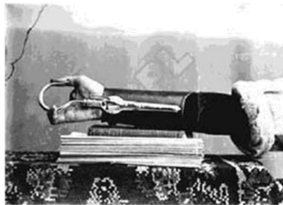
Figura 2.6: Prótesis de mano con pulgar móvil y gancho dividido sagitalmente.
