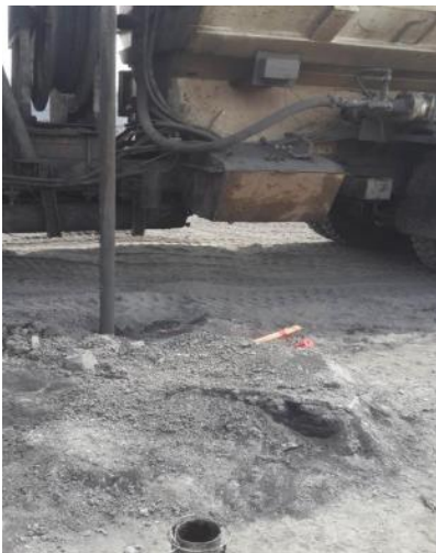
Figura 8. Cargue de Barrenos con Emulsión (Autor: Oscar Carrillo 2016)
