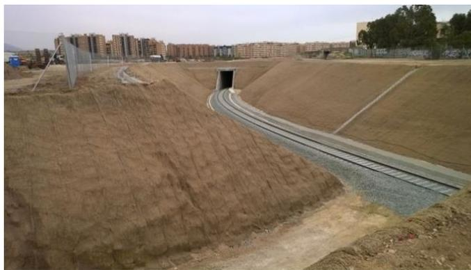
*Figura No 3. Talud de un terraplén*
