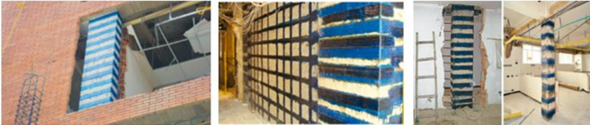
Ilustración 2(Refuerzo estructural INC de Bogotá)
