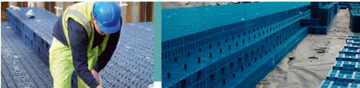
**Figura 3. Tanques de almacenamiento de Aguas Lluvias AquaCell. Fuente: PAVCO**
