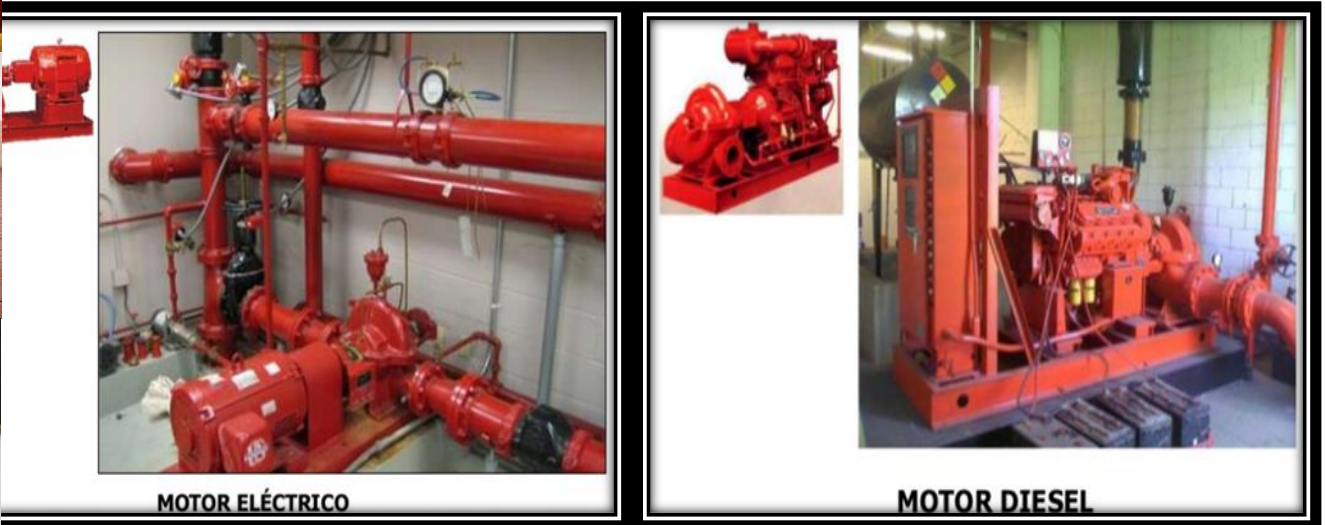
Imagen 2. Bomba eléctrica y diésel
