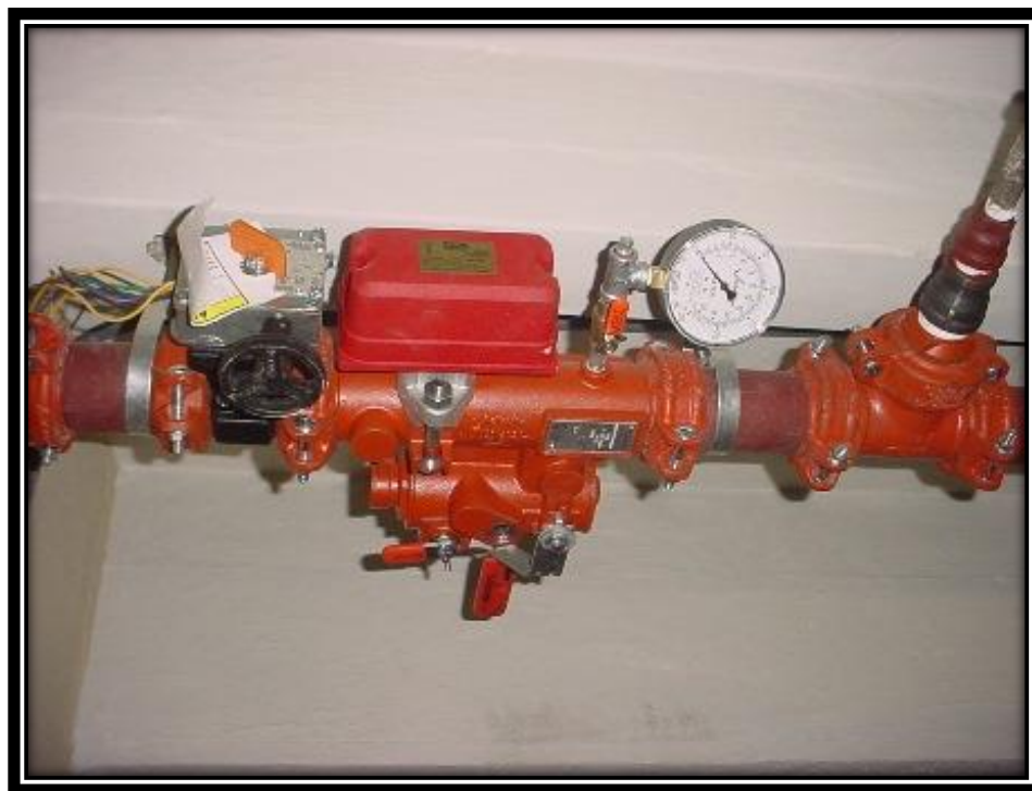
Imagen 5. Válvulas de control
