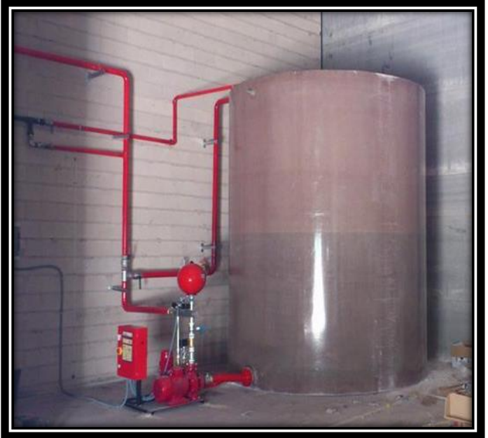
Imagen 1. Tanques de almacenamiento
