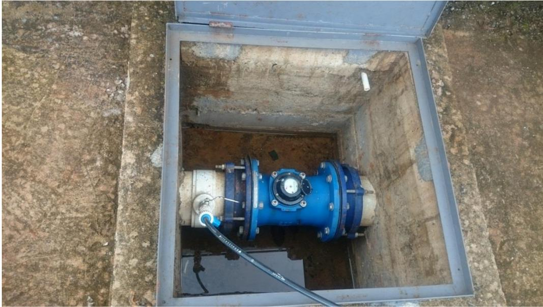
Ilustración 6. Vista del macromedidor de entrada de agua a la PTAP. Fuente: Tomada in situ
