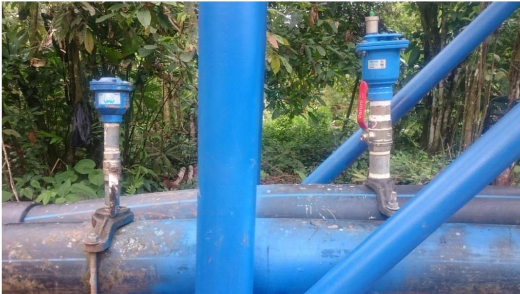
Ilustración 10. Vista de ventosas en la conducción del municipio de Bahía Solano.
