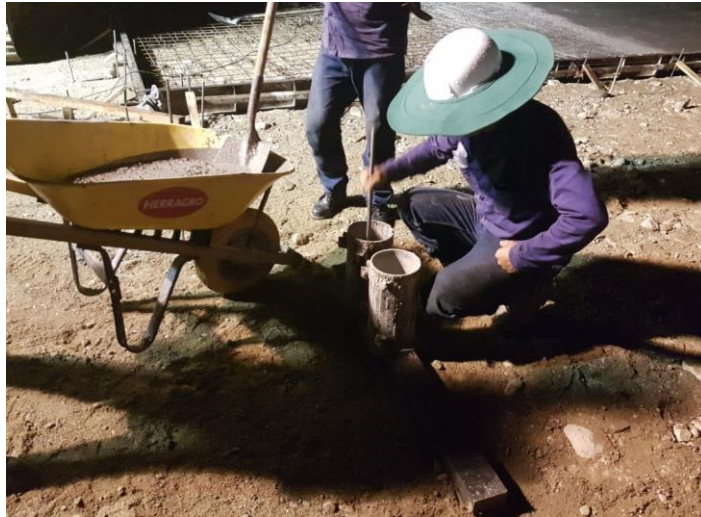
Figura 15. Toma de muestra de cilindros y losas (2).
