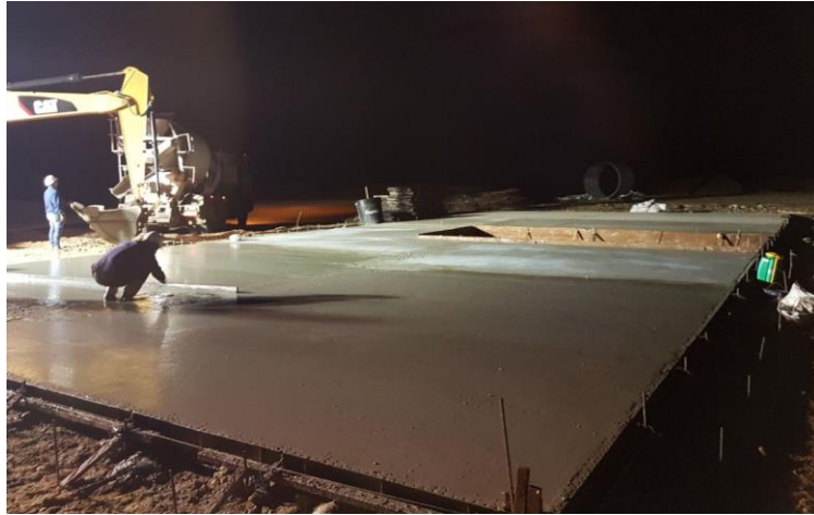
Figura 13. Fundición de placa en fibra sintética.
