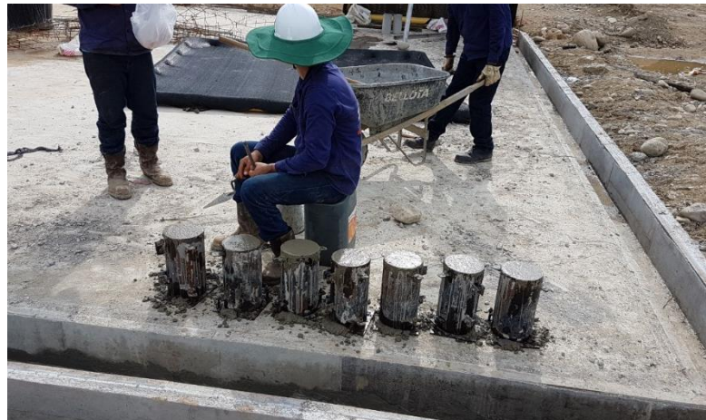
Figura 14. Toma de muestra de cilindros y losas (1).
