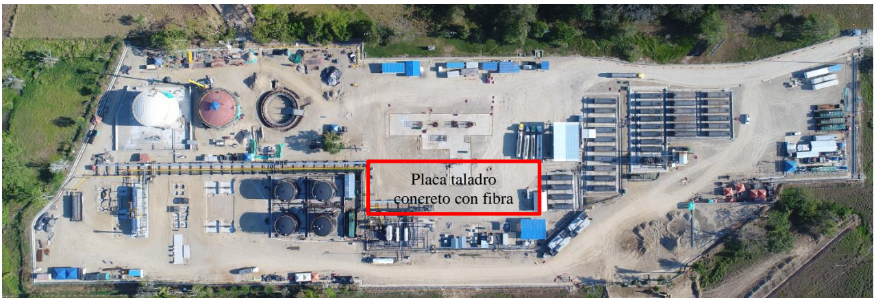
Figura 22. Localización acordeonero 1-3-5-7-8-9 estación del campo en proceso de construcción de todas las facilidades.
