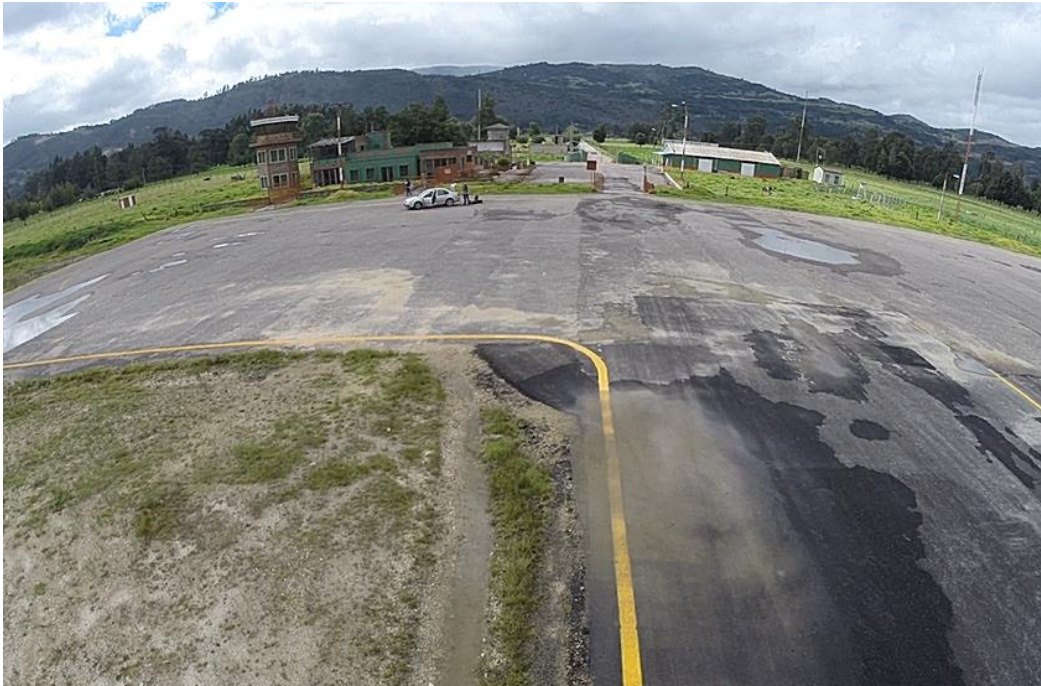
Foto Pista Aeropuerto Sogamoso
