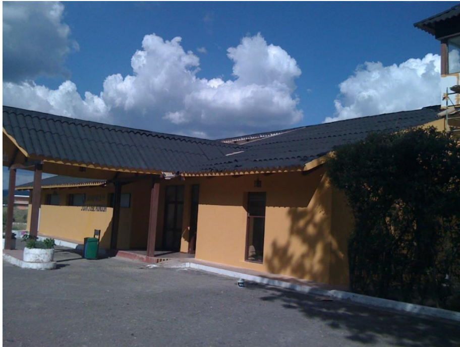
Foto Aeropuerto Paipa
