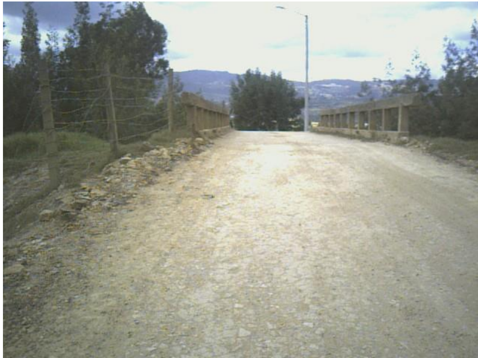
Ilustración 13: Puente de la vía Patio Bonito
