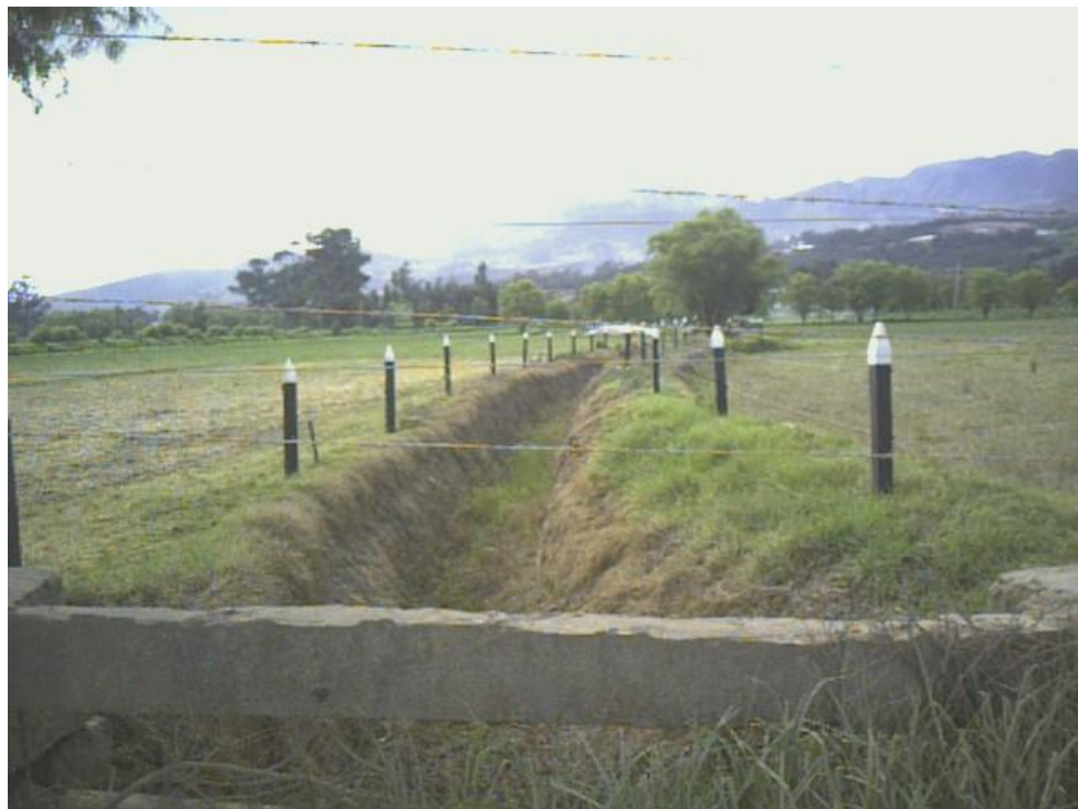
Ilustración 14: Obra de Drenaje en la vía Patio Bonito
