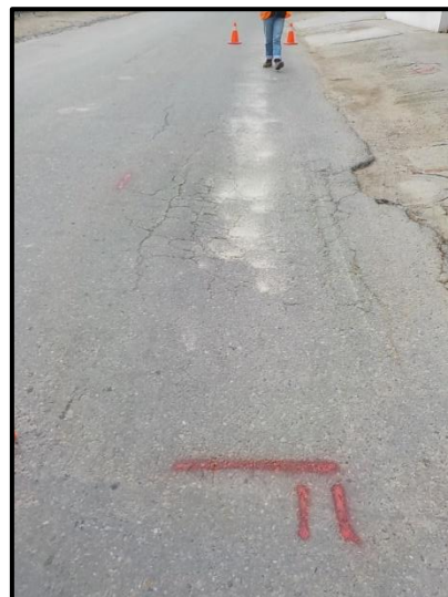
Imagen 17 Falla No 10 y 11 Hundimiento FUENTE: PROPIA
