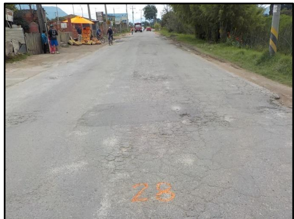
Imagen 25 Falla No 20 y 28 Reparación Total FUENTE: PROPIA
