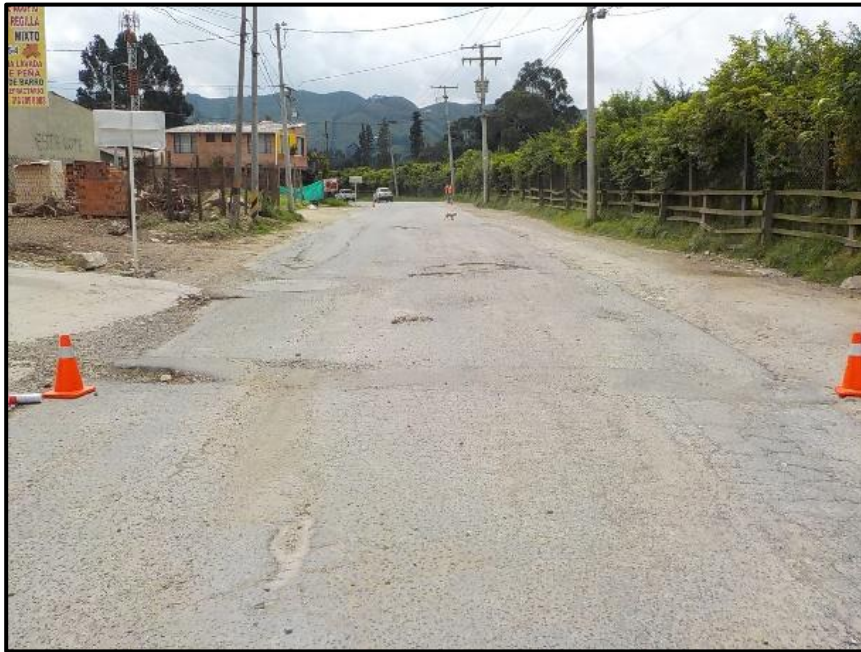
Imagen 26 Falla No 30 Reparación Total FUENTE: PROPIA
