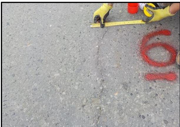
Imagen 13 Falla No 6 y 14 Fisura Longitudinal FUENTE: PROPIA
