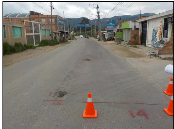
Imagen 13 Falla No 6 y 14 Fisura Longitudinal FUENTE: PROPIA
