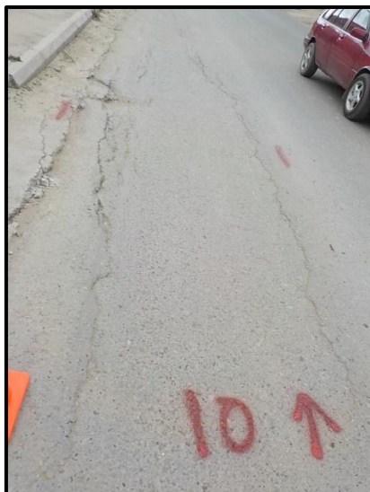
Imagen 17 Falla No 10 y 11 Hundimiento FUENTE: PROPIA
