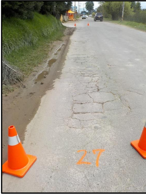
Imagen 24 Falla No 27 y Falla No 29 Fisura en bloque FUENTE: PROPIA
