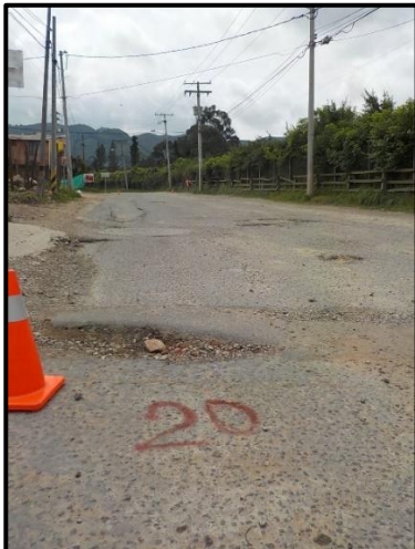
Imagen 25 Falla No 20 y 28 Reparación Total FUENTE: PROPIA
