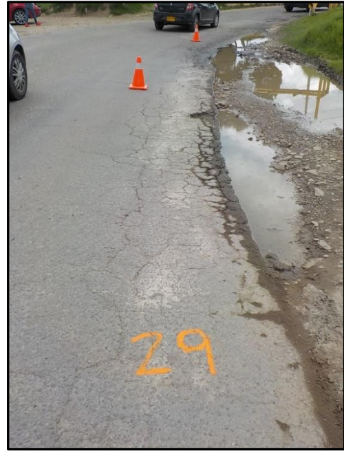
Imagen 24 Falla No 27 y Falla No 29 Fisura en bloque FUENTE: PROPIA
