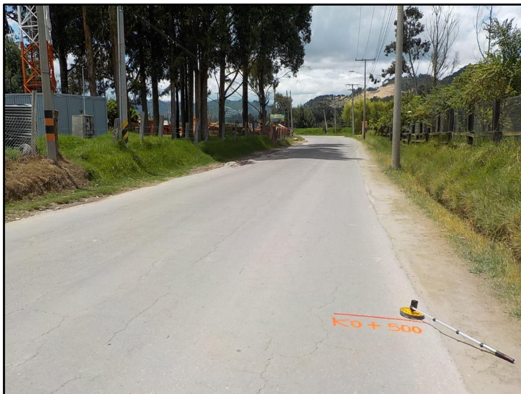
Imagen 4 Medición de Abcisado y Marcación en Campo FUENTE: PROPIA
