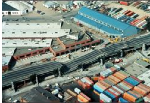
Figura 2.2 Autopista elevada colapsada
