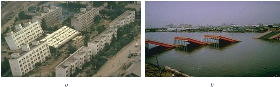
Figura 2.1 Inclinación y volcamiento producto de la licuación del suelo a) Edificaciones en Niigata; b) Puente colapsado de Showa
