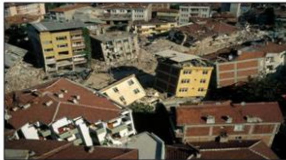
Figura 2.3 Edificaciones destruidas Golcuk
