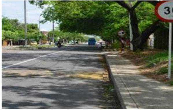
Ilustración 60: Carrera 7 calle 68- Resalto sin demarcación y sin pintura
