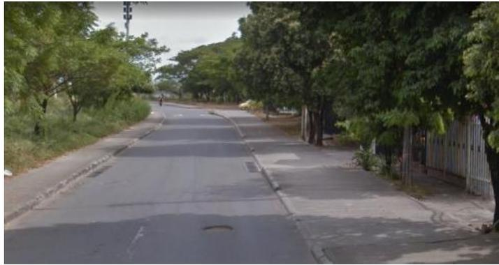
*Ilustración 34: Carrera 2 calle 72 – ausencia de iluminación- alcantarilla a desnivel
