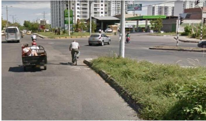
*Ilustración 54: Carrera 7 calle 55 – Ausencia de demarcación –Cruce semaforizada Fuente: Elaboración propia.*
