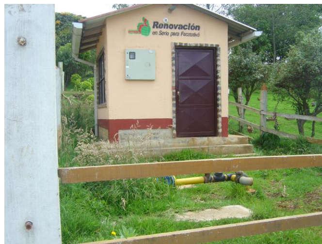
Vista Pozo, Tanque – Planta de Tratamiento 1
