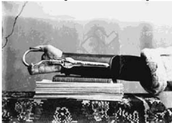
Figura 2.3: Prótesis de Mano con Pulgar Móvil y Gancho Dividido Sagitalmente.
