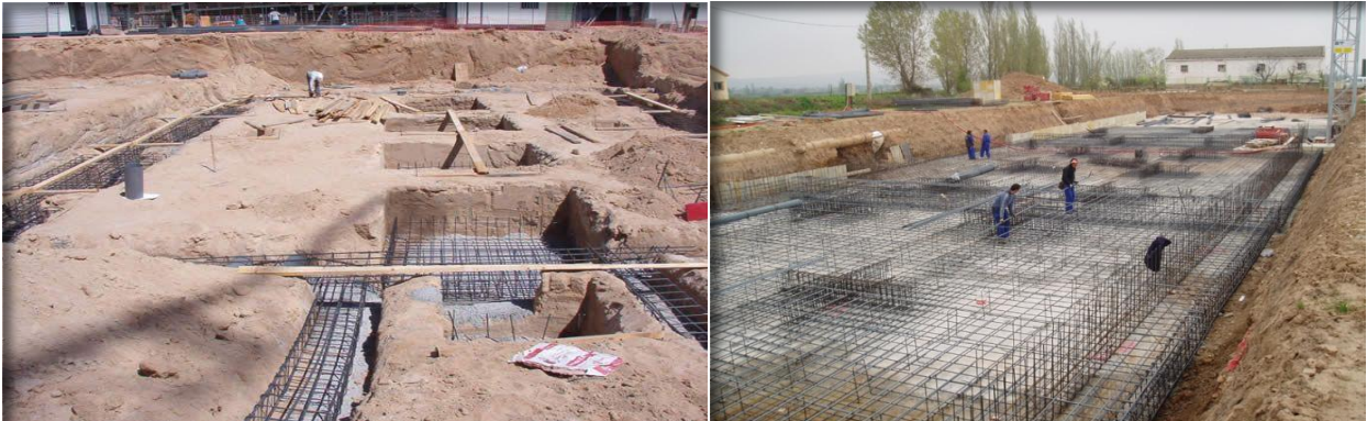
Figura 6. Proceso de cimentación.
