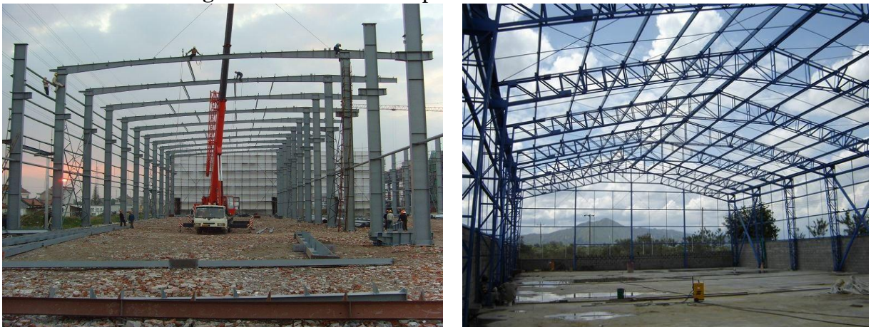
Figura.7 Estructura base para iniciar la construcción.
