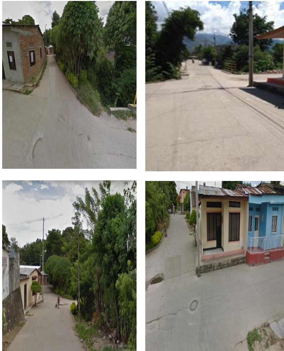
Ilustración 8: Problemática ausencia de señalización Calle 23- Carrera 14
