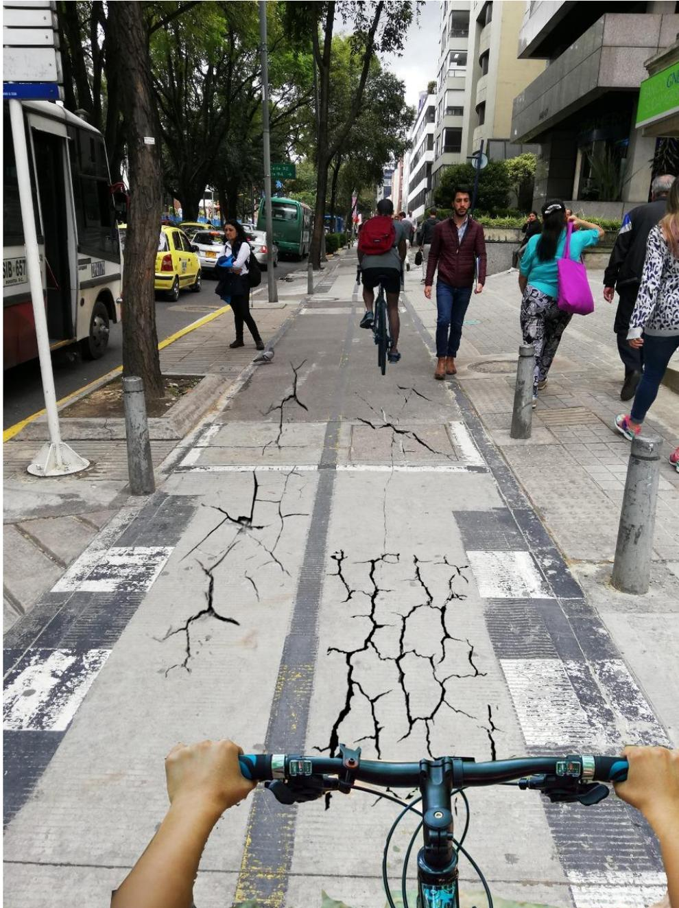
*Ilustración 22. Ciclo ruta tipo anden en mal estado*
