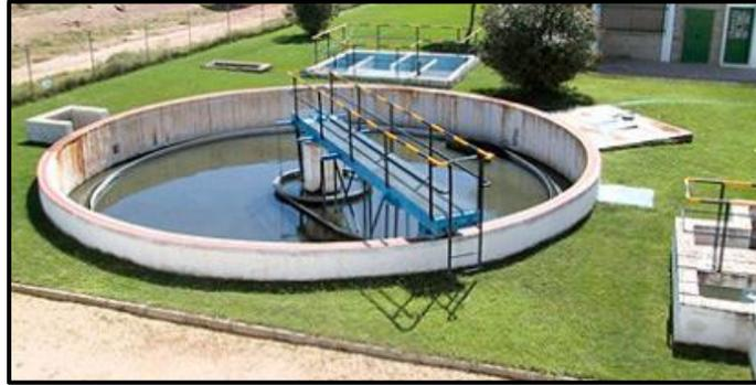
*Figura 10: Sedimentador primario. Obtenido de (Rojas, 2017).*
