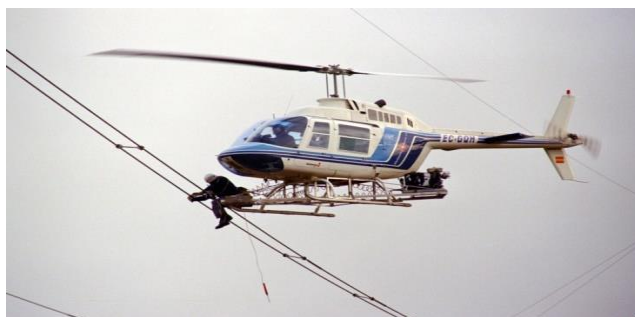
Figura 12. Trabajos de redes eléctricas Red eléctrica España. Tomado de Ree (2019)
