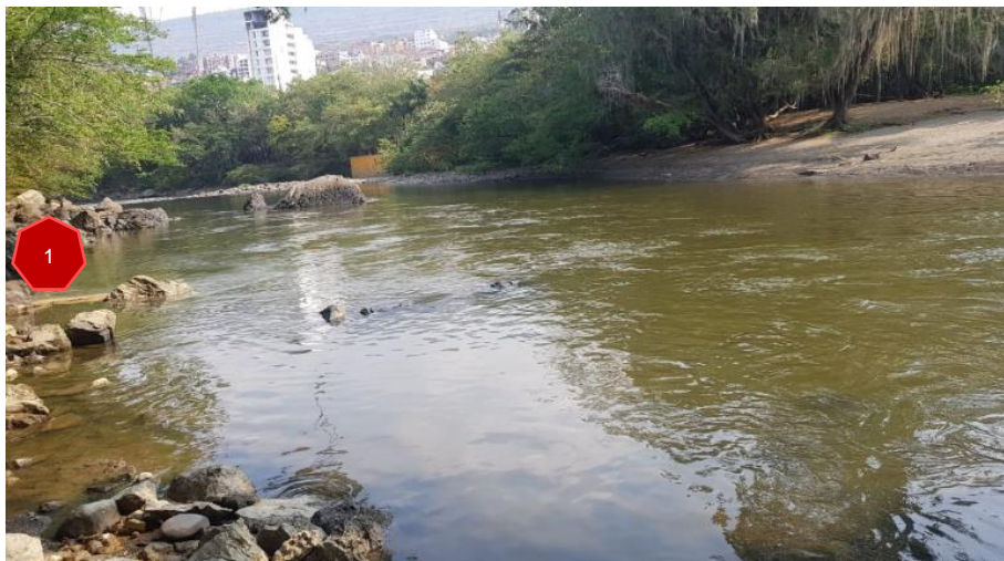
Fotografía 6. Sección del tramo 6 vertimiento del hotel Villa Real, Fuente propia.
