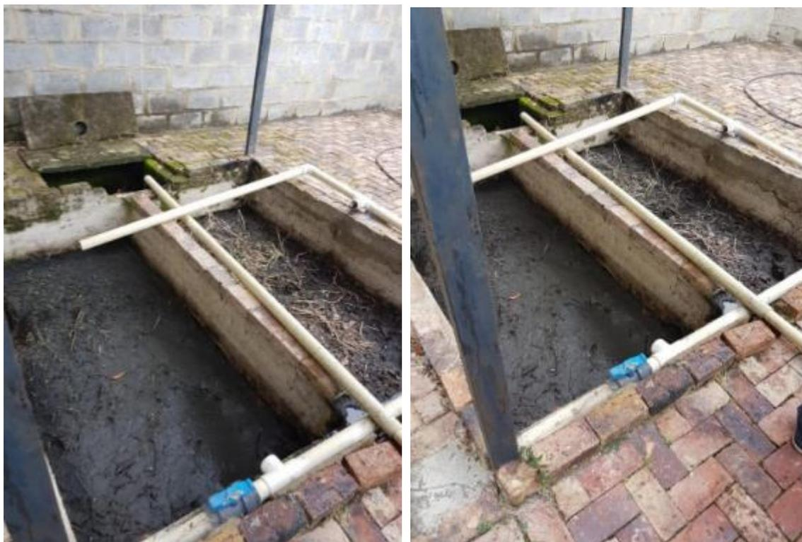
*Ilustración 14.* Lechos de secado. Fuente: elaboración propia.
