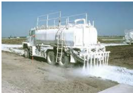
Ilustración 8: Estabilización Cemento y Cal.
