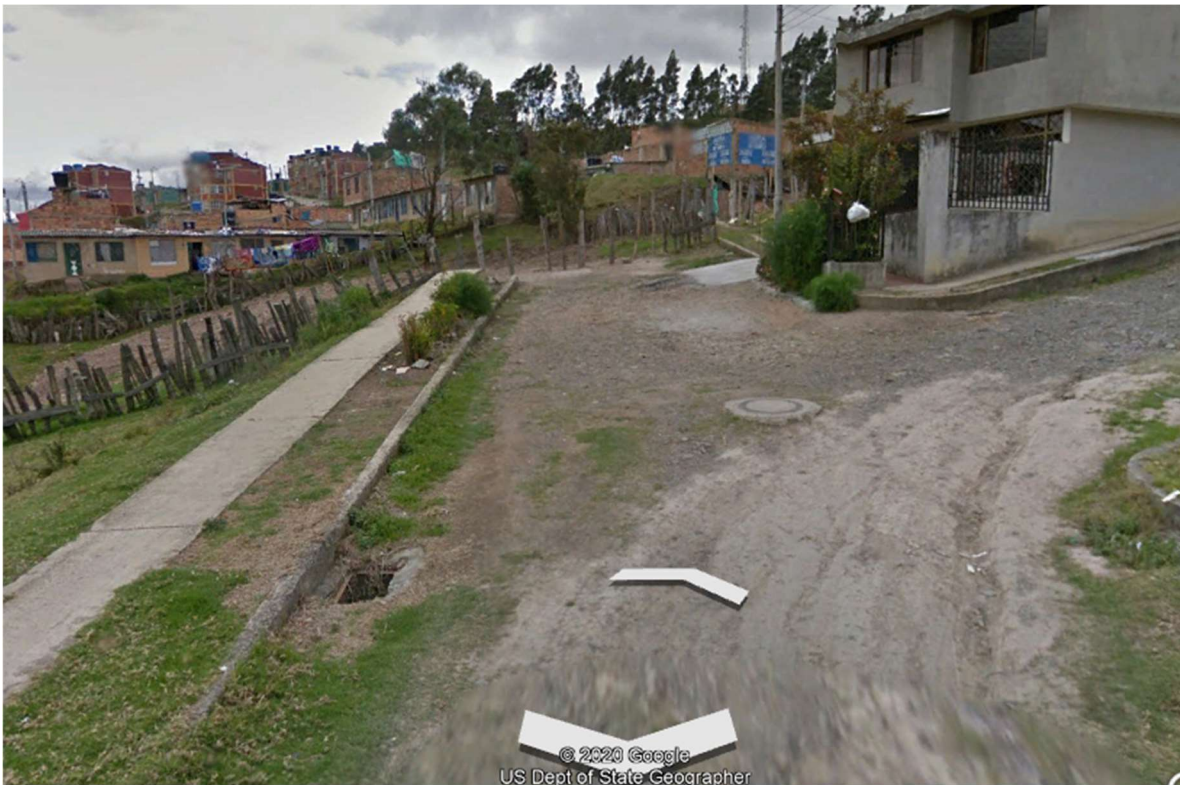
Figura 4 Vía a intervenir
