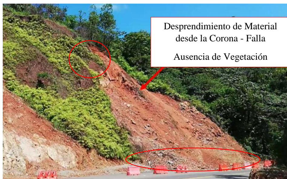
Figura 84. Sección Crítica entre K2+200 Unidad Funcional 2 Caucaasia – Zaragoza de Antioquia - Volumen V Estudio de Estabilidad y Estabilización de Taludes – 2015.
