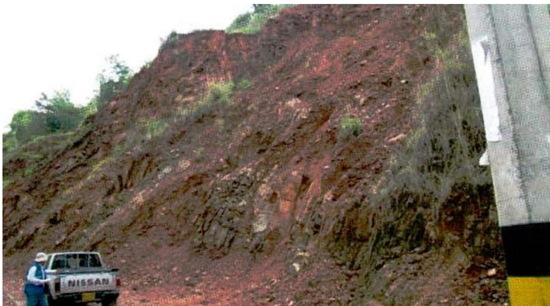
Figura 36. Talud K2+150. Volumen V Estudio de Estabilidad y Estabilización de Taludes – 2015.
