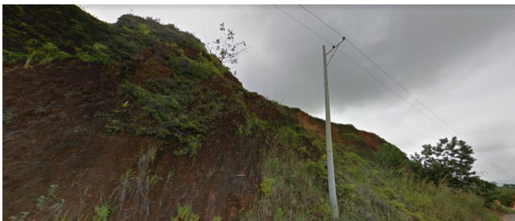
Figura 42. Talud K1+800 Perdida del material de Contención de revegetalización en la parte posterior a los gaviones al Final del Tramo. Google Earth 2020.
