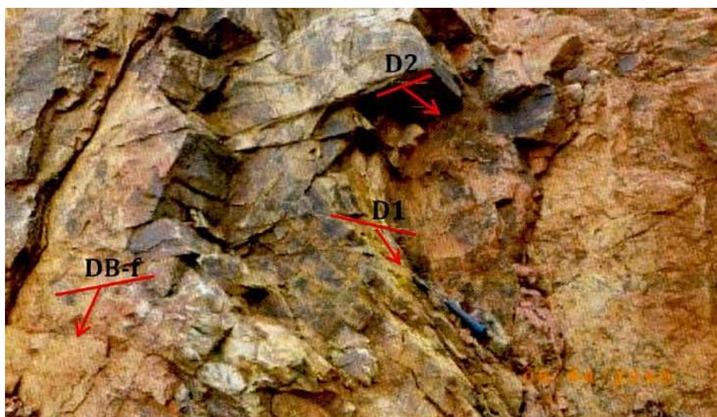
Figura 38. Talud K2+380. Volumen V Estudio de Estabilidad y Estabilización de Taludes – 2015.
