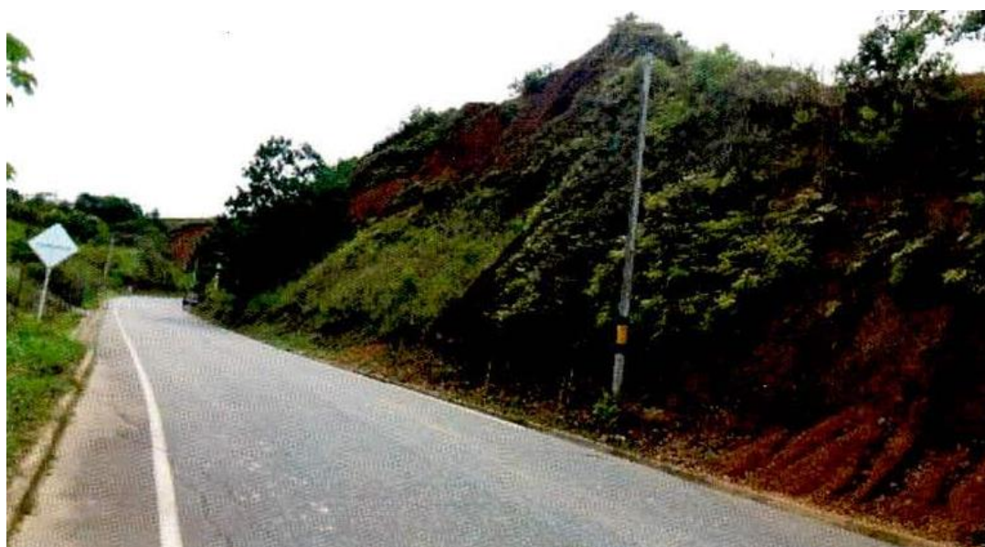
Figura 31. Talud K1+800 al Inicio del Sector. Volumen V Estudio de Estabilidad y Estabilización de Taludes – 2015.
