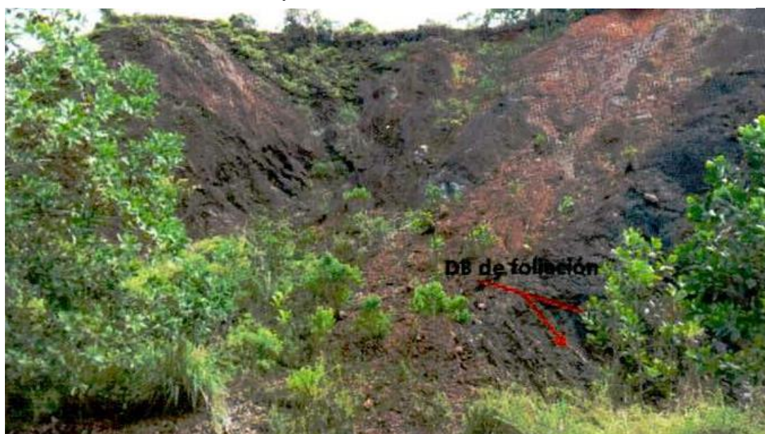
Figura 30. Talud Izquierdo K1+145 – K1+650. Volumen V Estudio de Estabilidad y Estabilización de Taludes – 2015.
