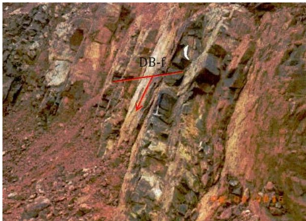
Figura 37. Talud K2+150. Volumen V Estudio de Estabilidad y Estabilización de Taludes – 2015.
