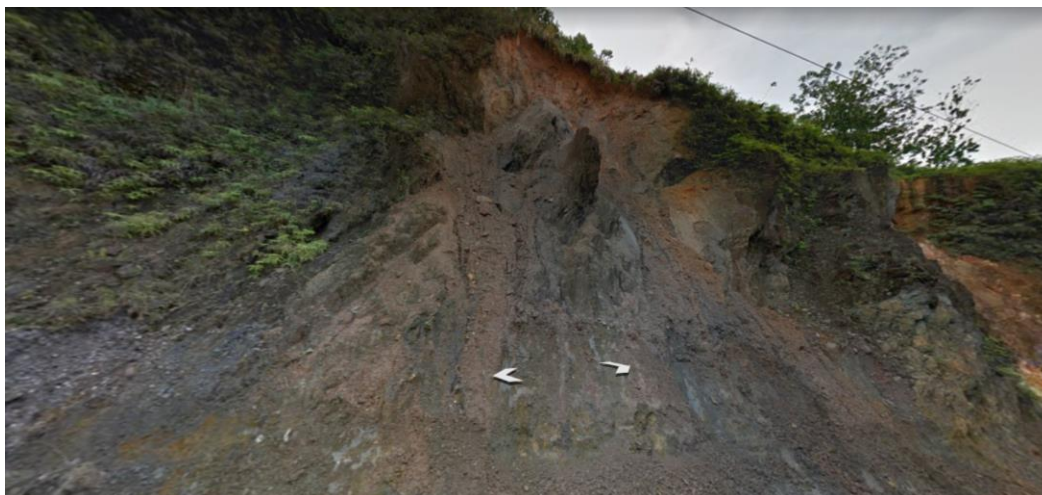
Figura 39. Talud Derecho K1+145 – K1+650 Deslizamiento de Material. Google Earth 2020.
