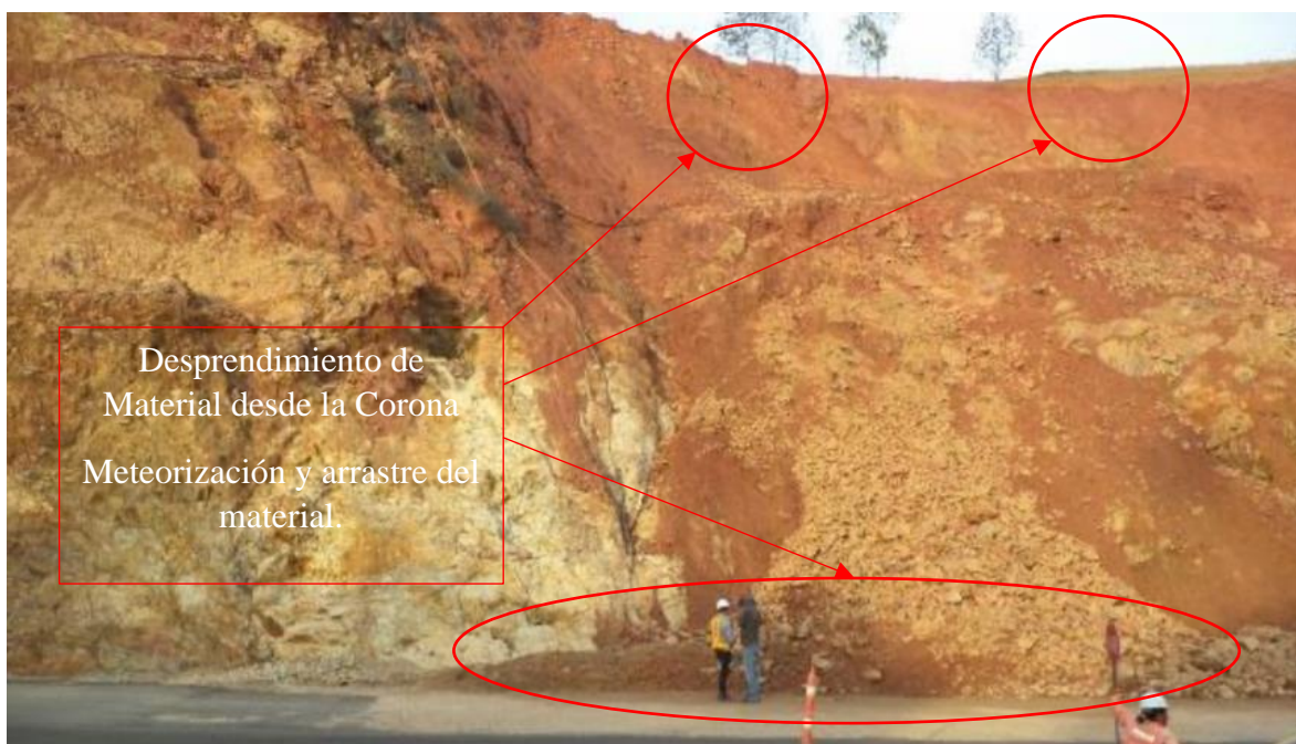
Figura 80. Sección Crítica entre K2+300 Unidad Funcional 2 Caucaasia – Zaragoza de Antioquia - Volumen V Estudio de Estabilidad y Estabilización de Taludes – 2015.
