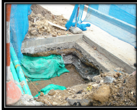
Foto 2. Caja con su Dimensionamiento para la Construcción del Sumidero.
