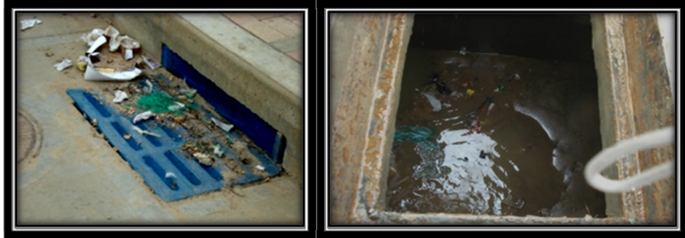
Foto 18 y 19. Condición del sumidero - caudal bajo.
