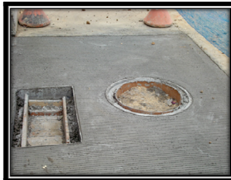
Foto 6. Fundida de la losa superior del sumidero.
