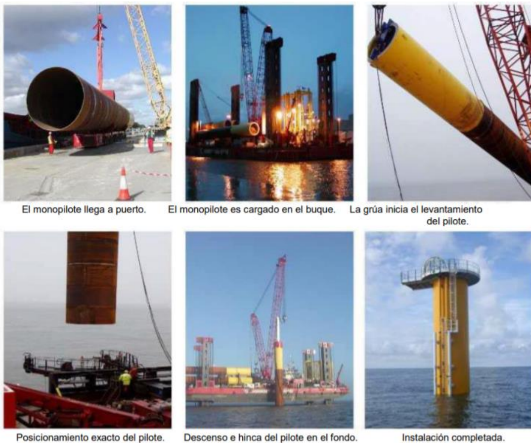
Figura 30 Proceso de instalación de mono pilotes
