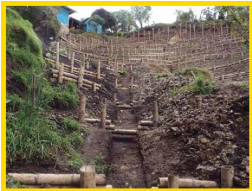
*Ilustración 28 Ejemplo de trinchos vivos en vertedero.*
