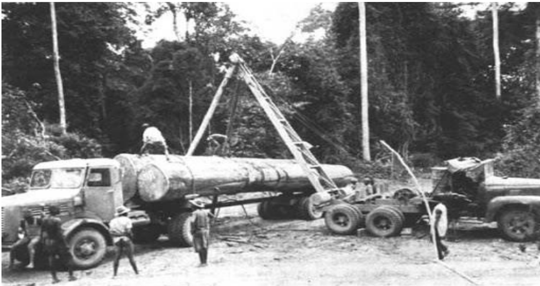
Figura 1. Levantamiento de carga en unas de las primeras grúas de arrastre creadas a base de madera.
