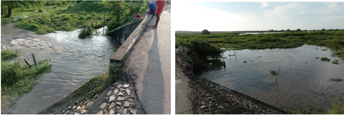
Figuras 30 y 31. Ingreso de agua por alcantarilla por drenaje directo del Brazo de Mompox. Fuente: Propia, tomada el 09-11-2021
