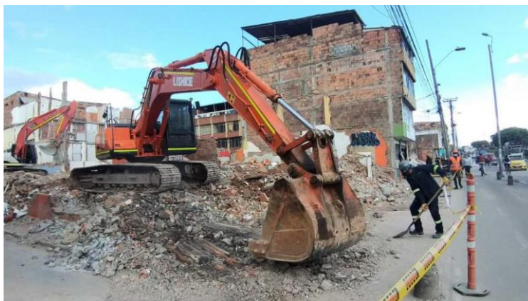
Figura 28 Demolición de predios para construcción del metro en Bogotá.
