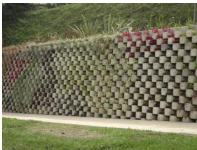
Figura 5 Ecomuros con concreto reciclado.
